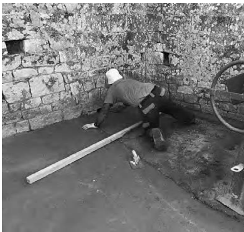
Figura 3-4 UT 2, area signorile, restauro della pavimentazione
