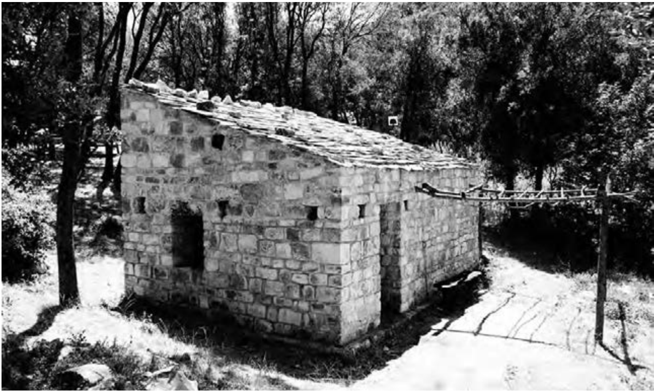
Figura 2 Abitazione realizzata utilizzando le antiche tecniche costruttive
