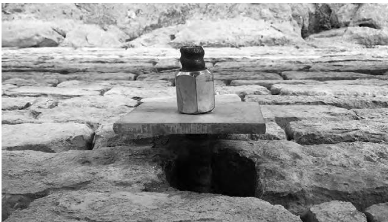
Figure 2-3 UT 4, chiesa, progetto e messa in opera delle chiodature
