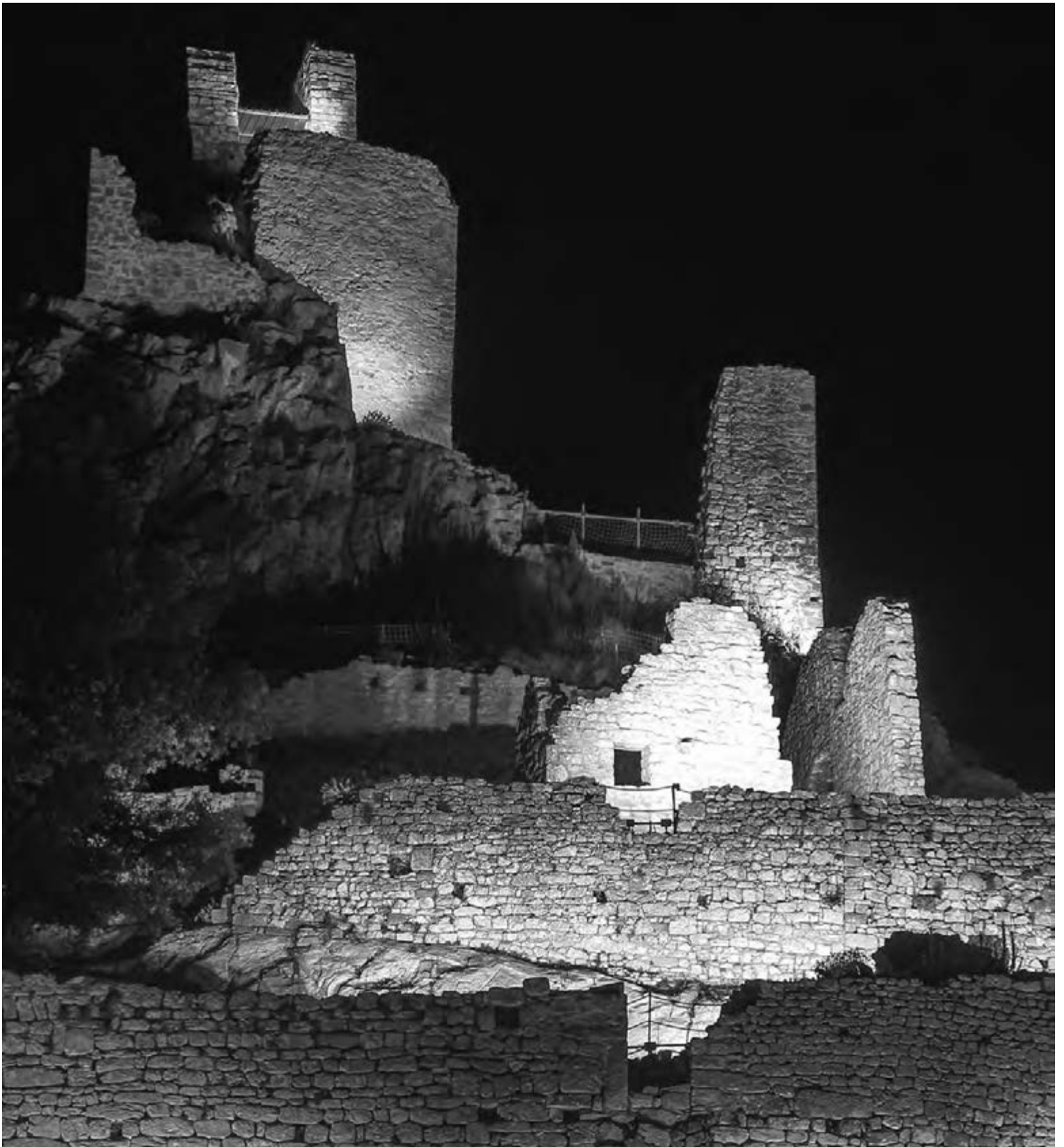
Figura 10 Rocca San Silvestro, Foto dopo i lavori di messa in opera del sistema di illuminazione
