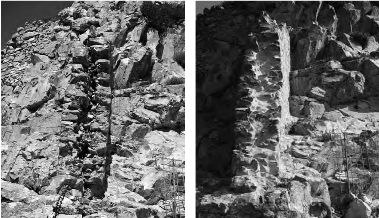
Figure 11-12 UT 7, intervento di consolidamento del muro soggetto a distacco dei paramenti
