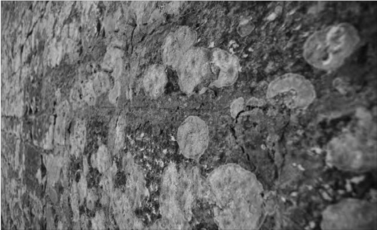
Figura 3 UT 4, chiesa, dettaglio di un paramento in opus incertum
