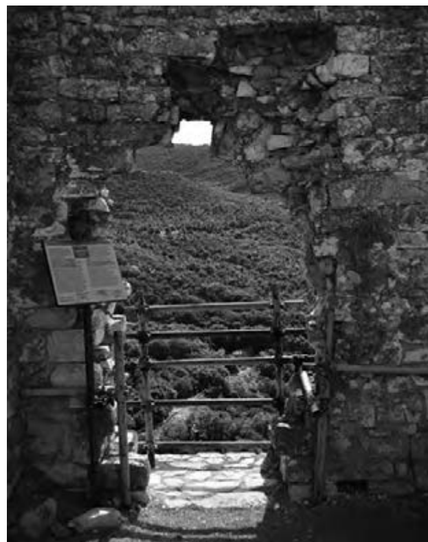
Figura 6 Ut 4, chiesa, foto della porta di accesso al presbiterio prima dei lavori di restauro
