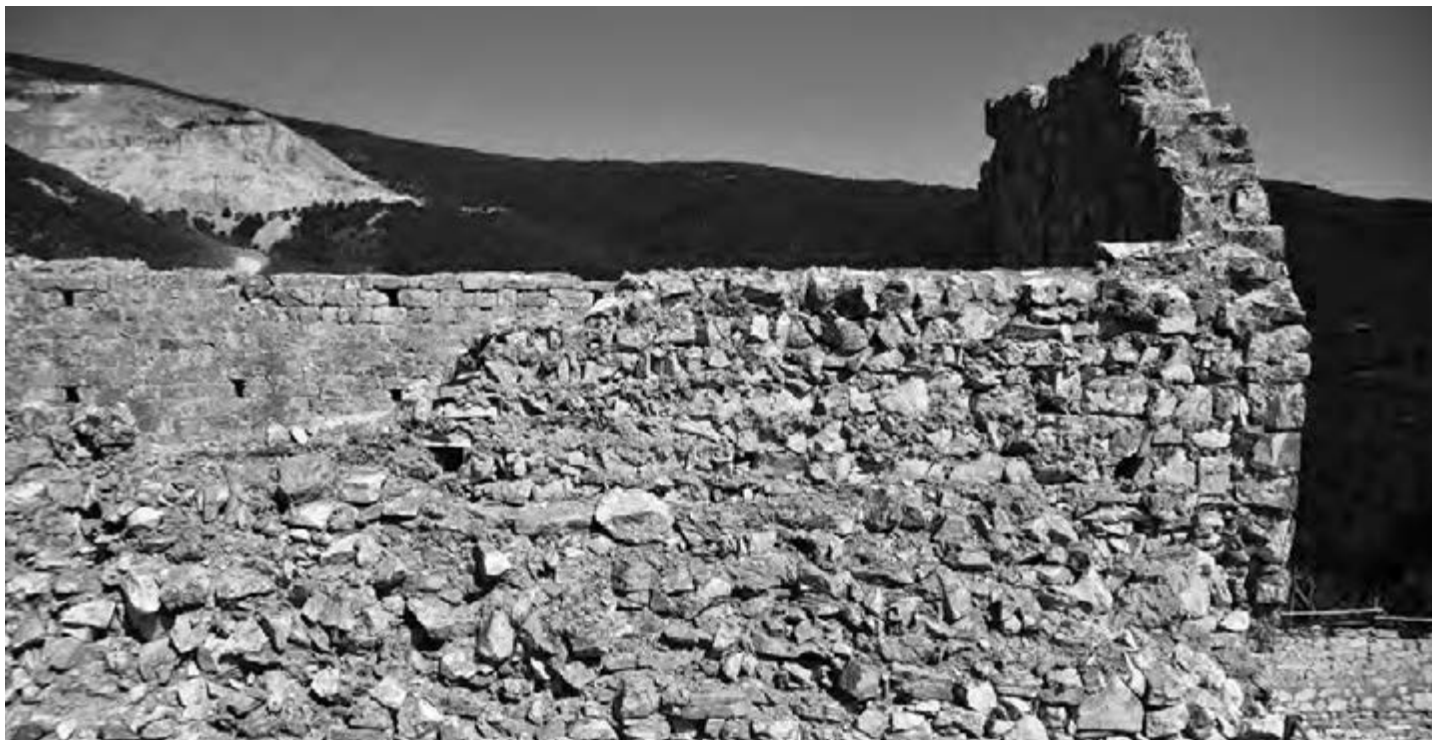
Figura 2 UT 4, chiesa, particolare di un palinsesto privo di giunti di malta di allettamento
