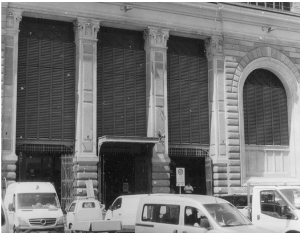
Fig. 86 Mercato Centrale di San Lorenzo, apertura centrale architravata (Uta Rüster, 2018).
