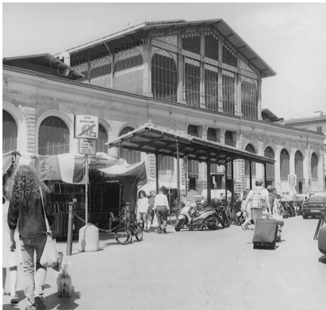
Fig. 146 Pensilina antistante ripristinata in una forma ridotta che ne compromette l'estetica e la funzione (Uta Rüster, 2018).
