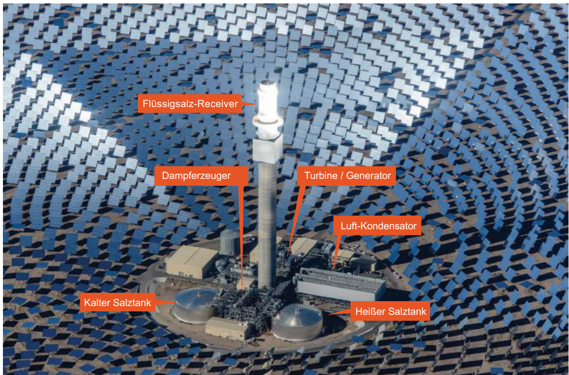
Abbildung 2.6.: Das Solarkraftwerk Crescent Dunes Solar Energy Project nahe Tonopah, Nevada [14].
