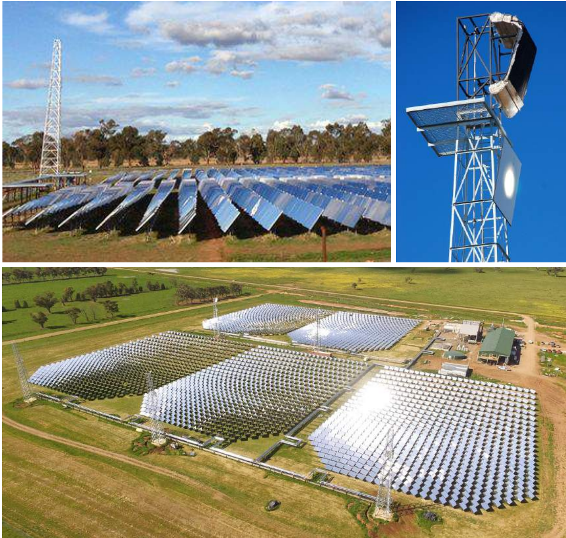
Abbildung 3.4.: Solarturmkraftwerk Jemalong Solar Thermal Station von VastSolar in Australien, Nähe Forbes [31]
