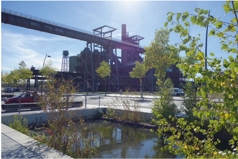
Abb. 8 Ehemaliger Hochofen Phönix-West, ein Leuchtturmstandort der Industriekultur im Östlichen Emschertal. (Foto: R. Hansen, 2018)
