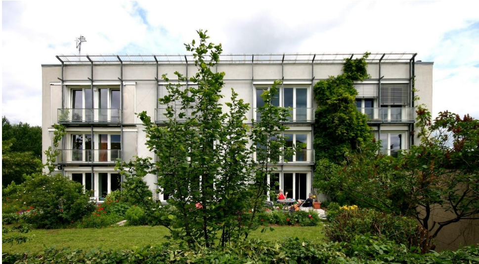
Abbildung 2 Südsicht des ersten Passivhaus-Wohngebäudes; vier Wohneinheiten sind reihenhausähnlich angeordnet. Entwurf: Architekten Bott/Ridder/Westermeyer Standort Darmstadt Kranichstein (kühl gemäßigt)(Foto: Feist 2006)
