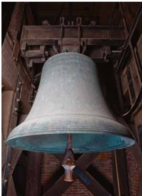
De Martinusklok in de Domtoren. Mogelijk was de afbeelding van Sint-Maarten oorspronkelijk naar de ruimte gekeerd, maar is de klok een keer gedraaid vanwege versleten slagvlakken. Dat gebeurde vaker bij oude luidklokken. Foto: Rob Huibers.
