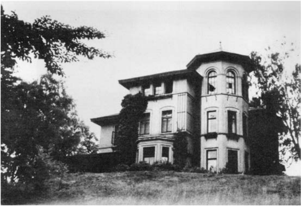
Wohnhaus von G. Hermann Stoltz in Wentorf, Hochweg 6 (1964 abgerissen)
