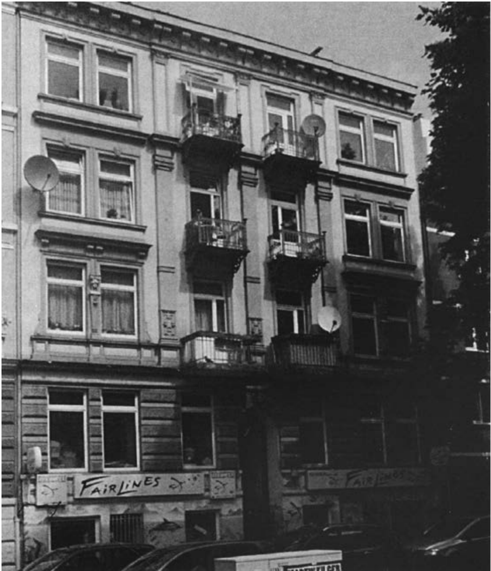
The house of the Samuel Lewisohn Stiftung at Kleiner Schäferkamp, Hamburg, today
