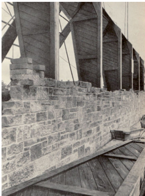
Abb. 4: Otto Bartning, Notkirche im Aufbau
