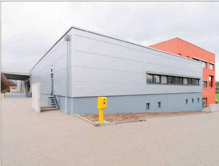
Abb. 6: Blick auf die Rückseite der Zentralapotheke mit dem für Schwerlastwagen geeigneten Rampenbereich der Warenannahme.
