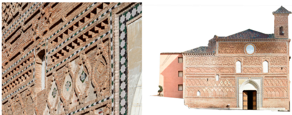
Fig. 03. Detalle de la ornamentación de la fachada principal y textura fotogramétrica del alzado sur. Iglesia de Santa María de Tobed. Elaborado por el Grupo de Investigación en Arquitectura (GIA) T37_17R.
