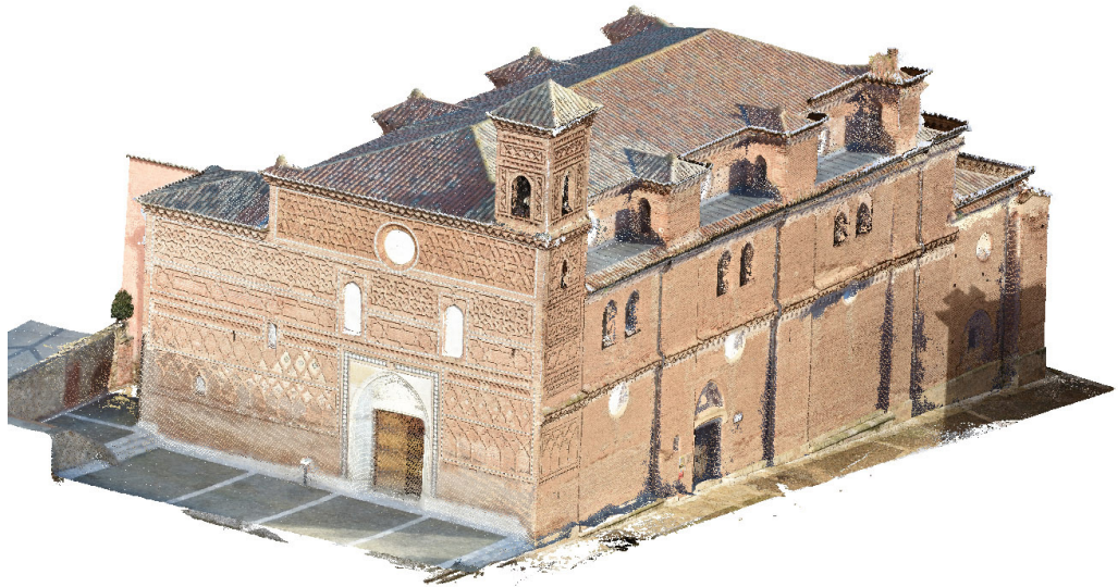
Fig. 04. Nube de puntos de alta densidad del exterior de la Iglesia de Santa María. Toma fotográfica se completó con la realizada mediante un dron Phantom 3. Grupo de Investigación en Arquitectura (GIA) T37_17R.
