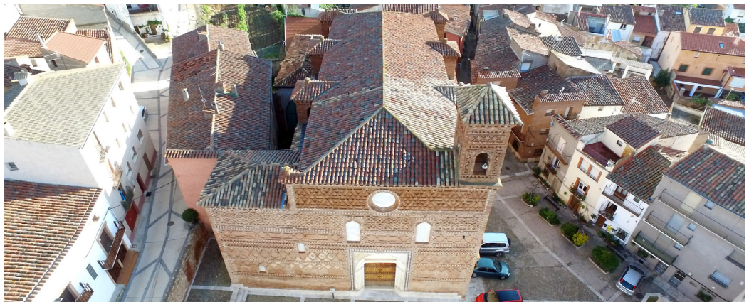
Aerial view of the exterior of the Church of Santa María de Tobed (Zaragoza). Grupo de Investigación en Arquitectura (GIA) T37_17R.
