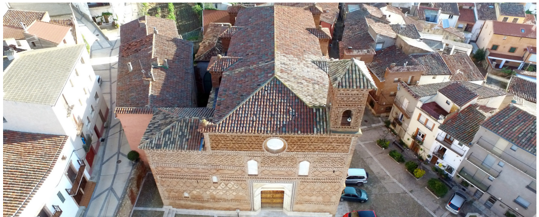
Vista aérea del exterior de la Iglesia de Santa María de Tobed (Zaragoza). Grupo de Investigación en Arquitectura (GIA) T37_17R.
