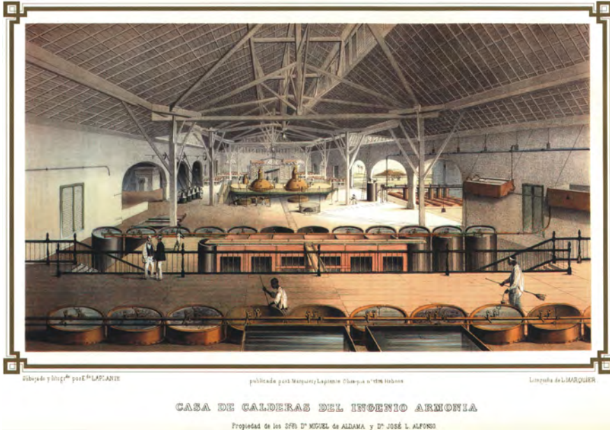
Abb. 6a: Casa de calderas des ingenio Armonía.
