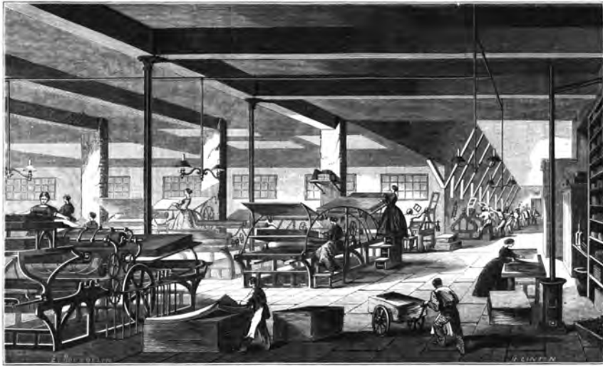
IMPRIMERIE IMPERIALE. — Salle des presses mécaniques.
