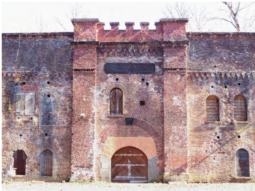
Abb. 2: Fort im äußeren Festungsring bei Köln-Mülheim, Foto 2022.
