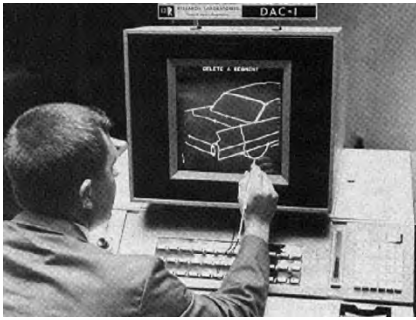
3 Computer Aided Design mit dem DAC-1
