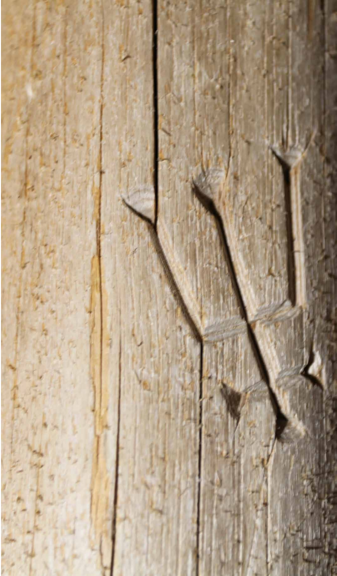
Huolellisesti veistetty puumerkki Keminmaan vanhan kirkon kattorakenteen itäpään yläosassa suoraan alttarin yläpuolella rakenteen harjalla (1550-luku). Kuva: Laura Laine.
