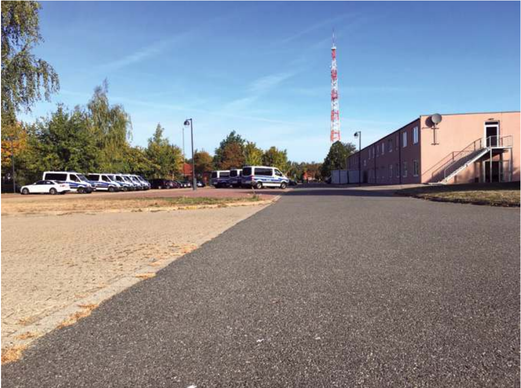
Abb. 14: Fahrweg auf der Anlage der Polizei Niedersachsen, Lüchow (Quelle: eigenes Bild)
