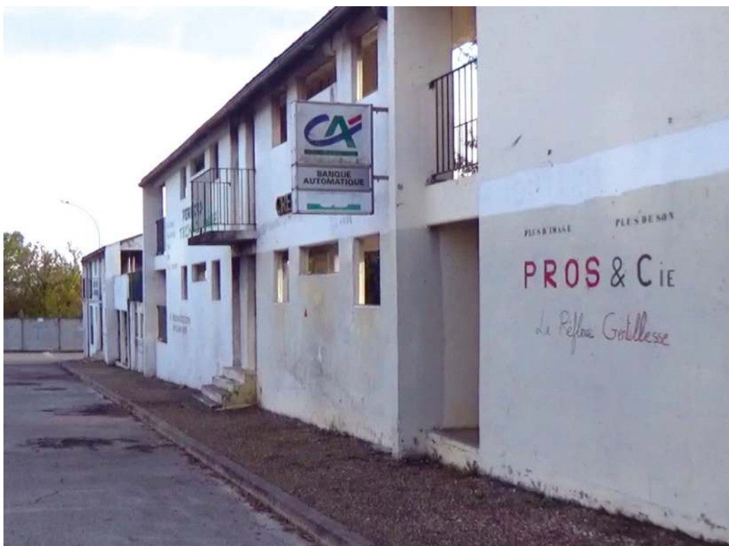
Abb. 11: Hauptstraße von pôle 1 im französischen CNEFG, Saint-Astier (Quelle: eigenes Bild)
