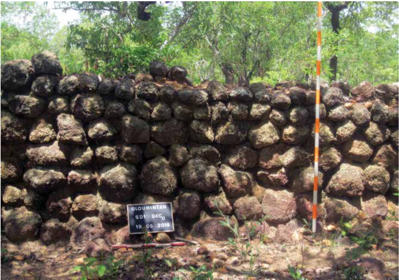
Figure 3.7. Muret de pierre à Glouhintan (avec l'aimable autorisation de L. Adou).
