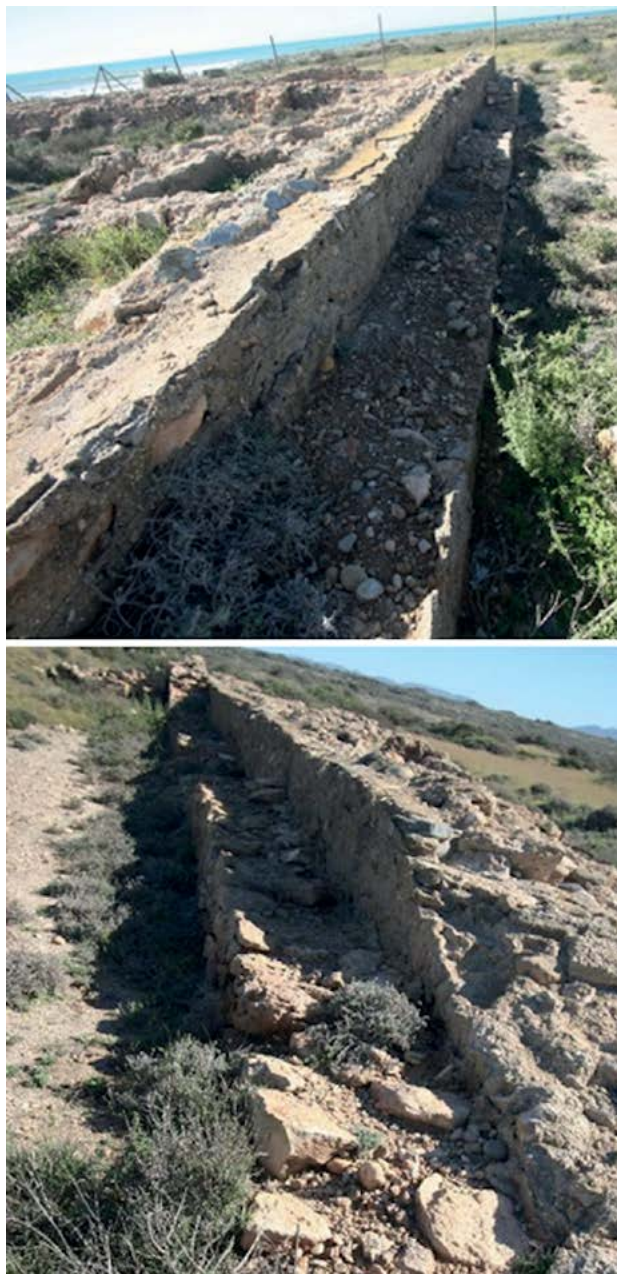
Figura 4.9. Área 1 de la Zona A: imágenes del muro perimetral.
