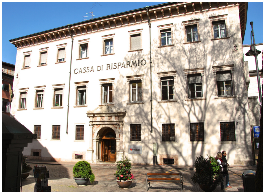
Figura 2. Palazzo Firmian a Trento. Foto di Luisella Decarli. Comune di Trento.
