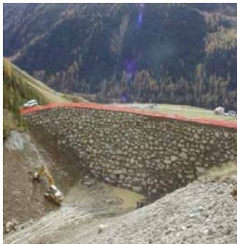
Abbildung 1, Maßnahmen der Wildbachverbauung, Pflasterungen und Konsolidierungssperren
