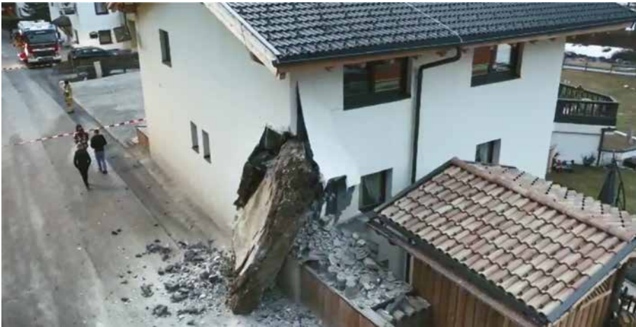
Abbildung 4, Schadblock mit ca. 8 m 3 und beschädigtes Gebäude;
