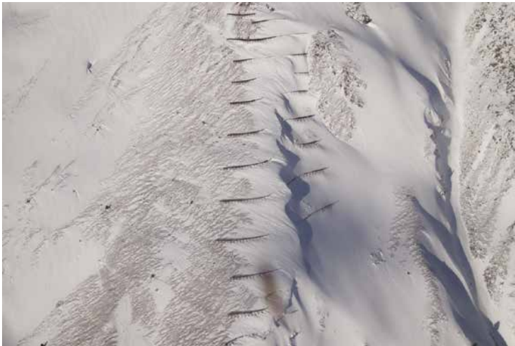
Bild 2, Intensive Bewindung führt zu starker Verfüllung der Anbruchverbauungen (Beispiel Sellraintal)
