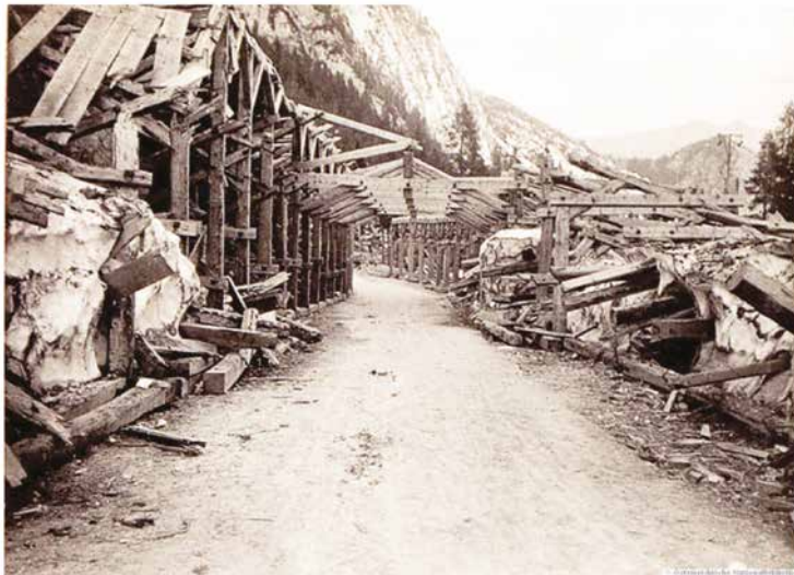
Bild 4, Zerstörte Lawinengalerie am Mojstrovkapass in den Julischen Alpen
