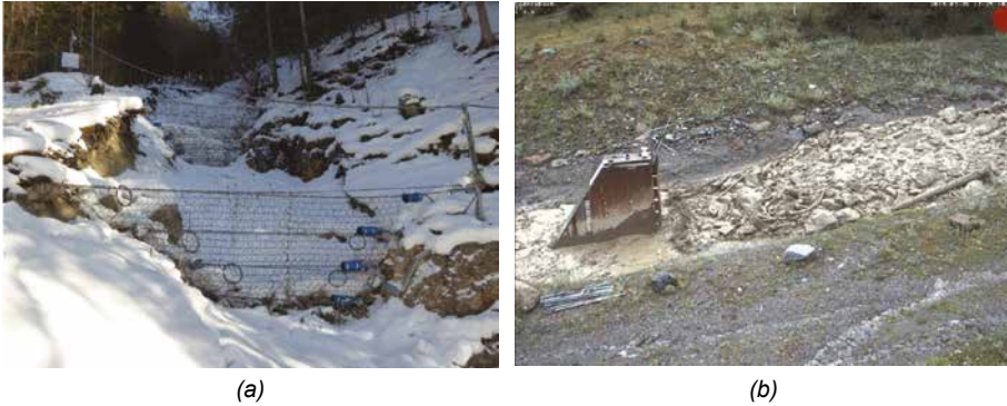
Bild 3, (a) Monitoringsystem an Murennetz Bayern, (b) Murenmonitoringstation in der Gadria, Südtirol (BOKU)
