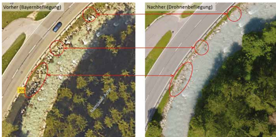
Abb. 5: Vorher-Nachher-Vergleich der Orthofotos der Bayern- und der Drohnenbefliegung mit Fehlstellen im Kolkchutz
