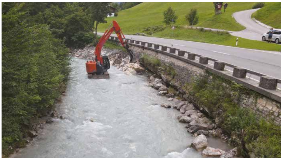
Abb. 6: Sanierung des Kolkshiftes des in Abbildung 5 dargestellten Bereiches im August 2021
