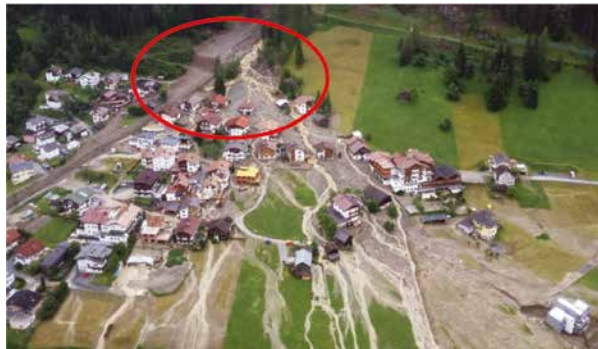
Bild 7, Bauwerksversagen Schallerbach (See, 2015)
