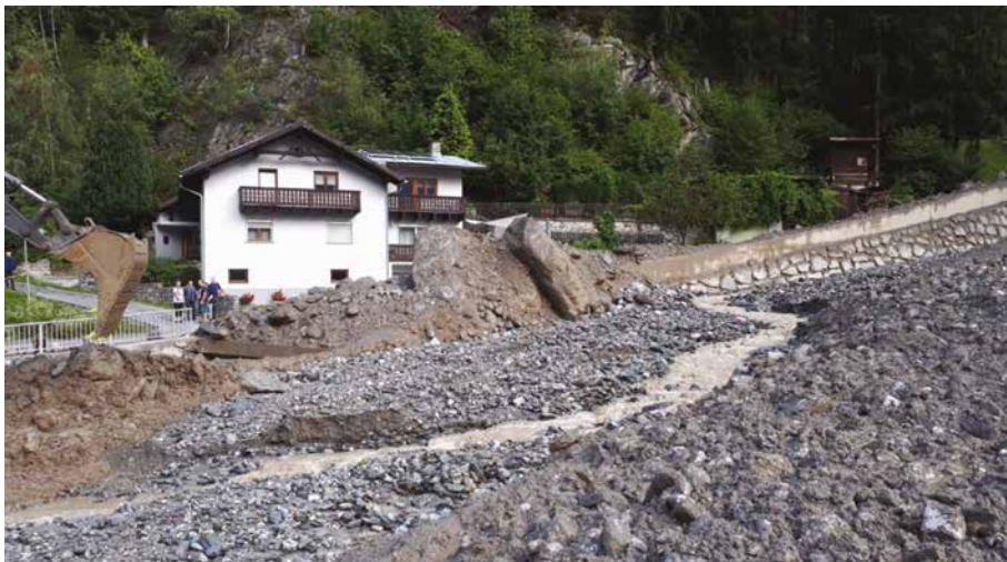
Abbildung 2, Dawinbach, Ablagerungen von Großblöcken i.Z. des Murganges vom 31.08.2019
