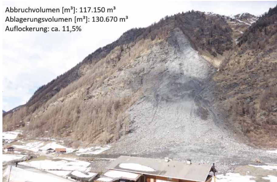
Bild 4: Felssturz Vals, Abbruchvolumen ca. 117.000m 3 , max. Sturzhöhe ca. 360 m (Preh et al. 2020)
