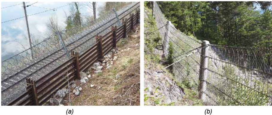
Bild 1, (a) Bauwerke der Phasen 4 (Steinschlagschutznetz) und 2 (Schienenwand), (b) Bauwerk der Phase 3 (Drahtseilsperre mit starrem Stützenfuß)
