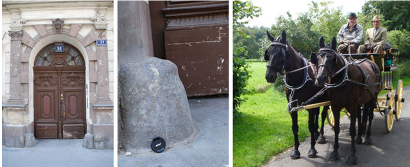
Abbildung 5.10 Toreinfahrt mit zwei Radabweisern, kulturelle Sinnkapsel „Radabweiser“, Break-Kutsche mit eisenbereiften Wagenrädern 4 (v.l.n.r.). (Fotos: Thomas Möllers CC BY-SA 4.0)
