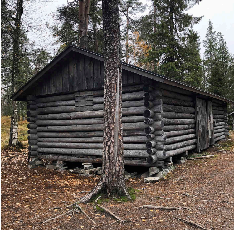
Kuva 14. Huoltorakennus luontomatkailureitin varrella. Hirsirakennus voidaan tarvittaessa purkaa osiin ja koota uudelleen toiseen sijaintiin. Kuva: Nina Aarras.
