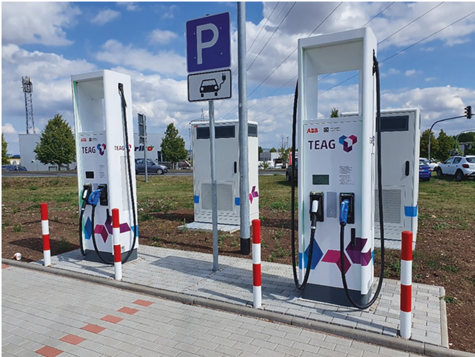
Abb. 24.5 DC-Schnellladestation mit zwei Säulen inklusive jeweils einem CCS- und einem CHAdeMO-Anschluss. (Vgl. Aschroet 2019)
