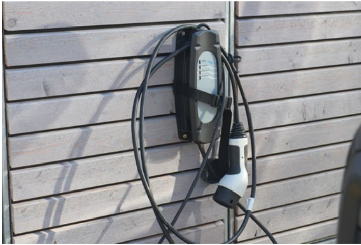
Abb. 24.3 Wallbox mit einem fest installierten Typ2-Stecker. (Vgl. Marschmensch 2020)
