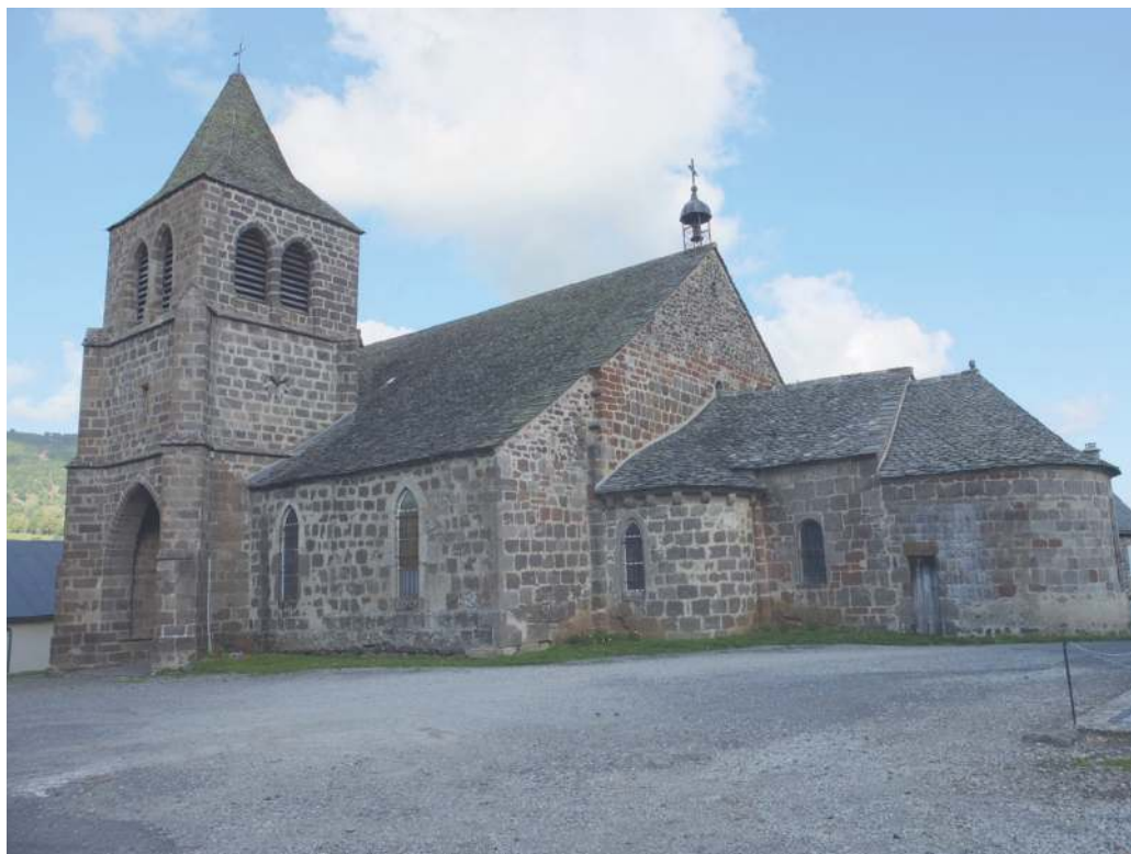
Abb. 1: Eine der prägenden romanischen Kirchen im Cantal (Foto: Martin Büdel)
