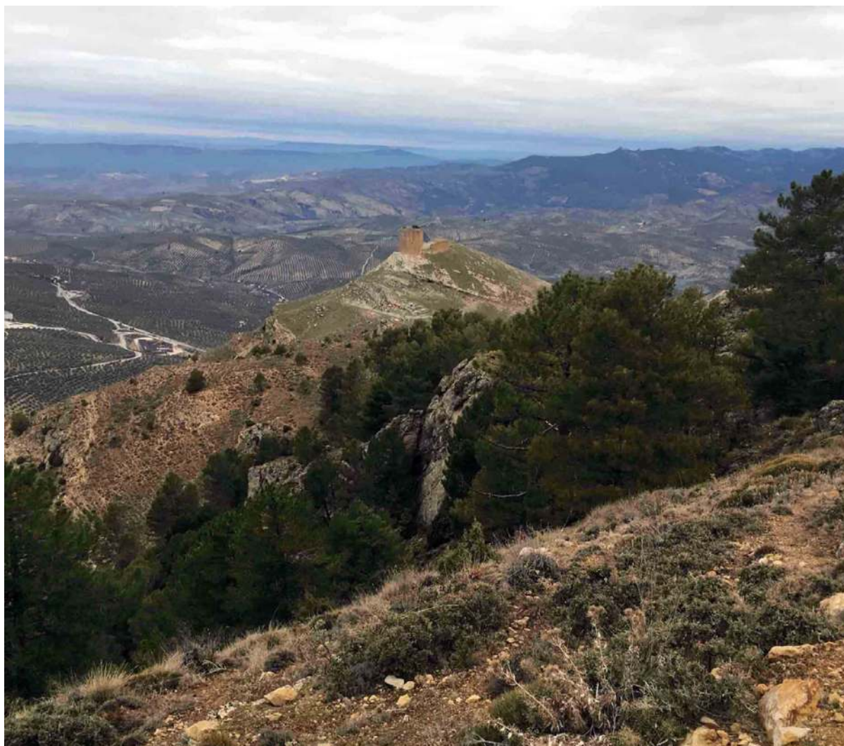
Figura 3. Castillo de las Cinco Esquinas (Cazorla) y valle del Rio Cerezuelo. Fotografía del autor.
