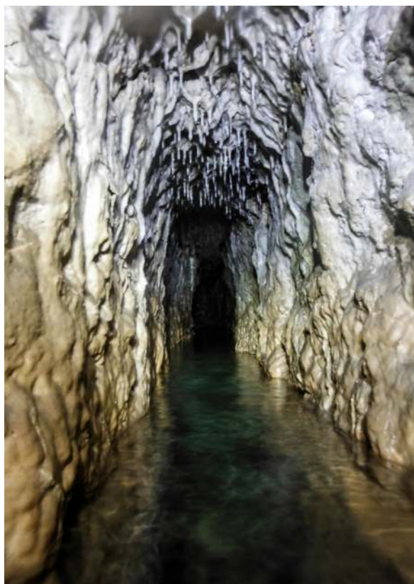
Figura 2. Galería de la mina de San Antón. Fotografía de M. Bernal, Asociación Andaluza de Exploraciones Subterráneas.
