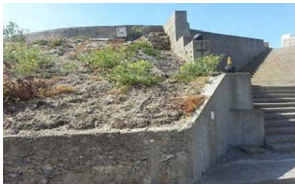
Figura 37: 2013. Torregorda. Base de la fortificación, detalle 2 Fuente: Fotografía de producción propia.
