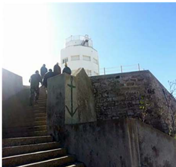
Figura 36: 2013. Torregorda. Base de la fortificación, detalle 1 Fuente: Fotografía de producción propia.
