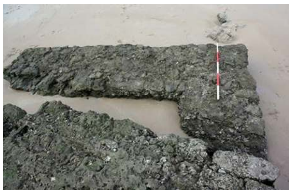
Figura 44: 2013. La Albufera en bajamar. Detalle de la unidad constructiva B Fotografía de Francisco Ghersi García.
