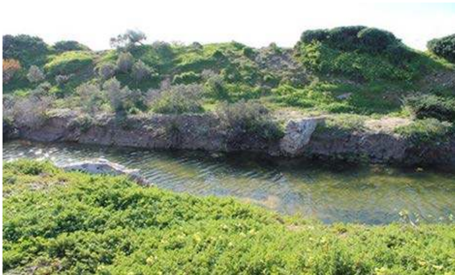
Figura 30: 2013. Pretil de la Calzada de la Alcantarilla seccionado al construir la gavia o canal de Camposoto a fines del siglo XX
