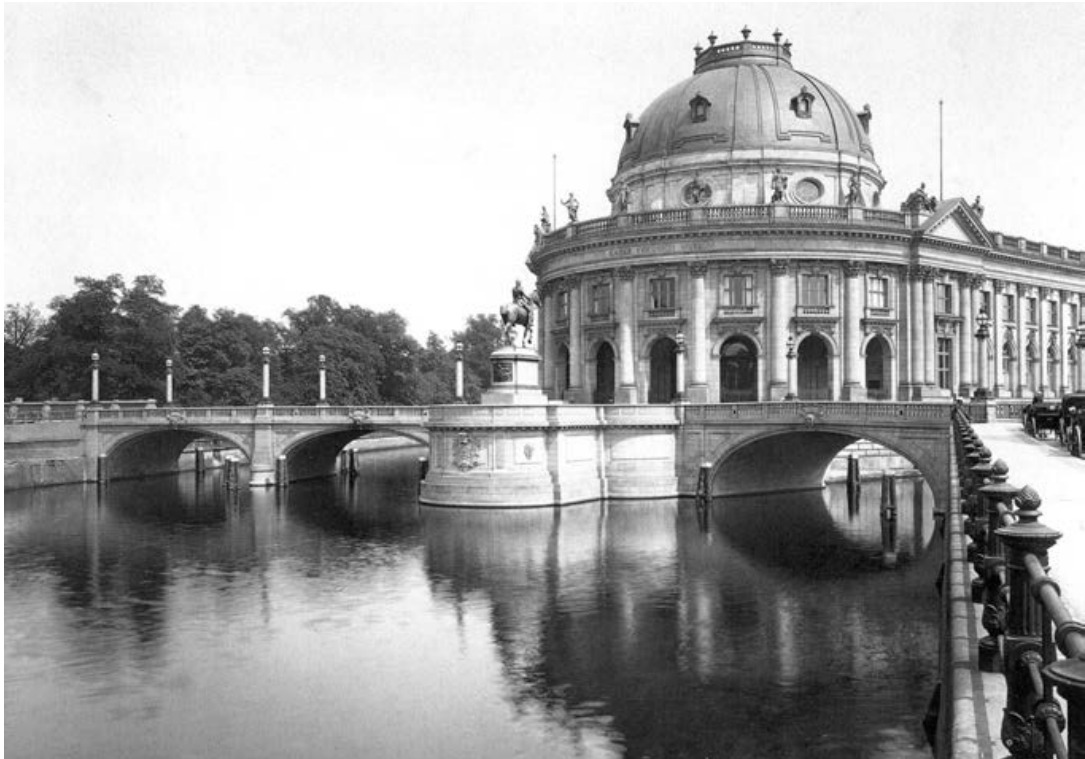
Bild 4.7: Kaiser-Friedrich-Museum Berlin (heute Bode-Museum) von der Ebertsbrücke (Nordseite), Architekt: Ernst von Ihne, erbaut 1898-1904, Foto: 1905
