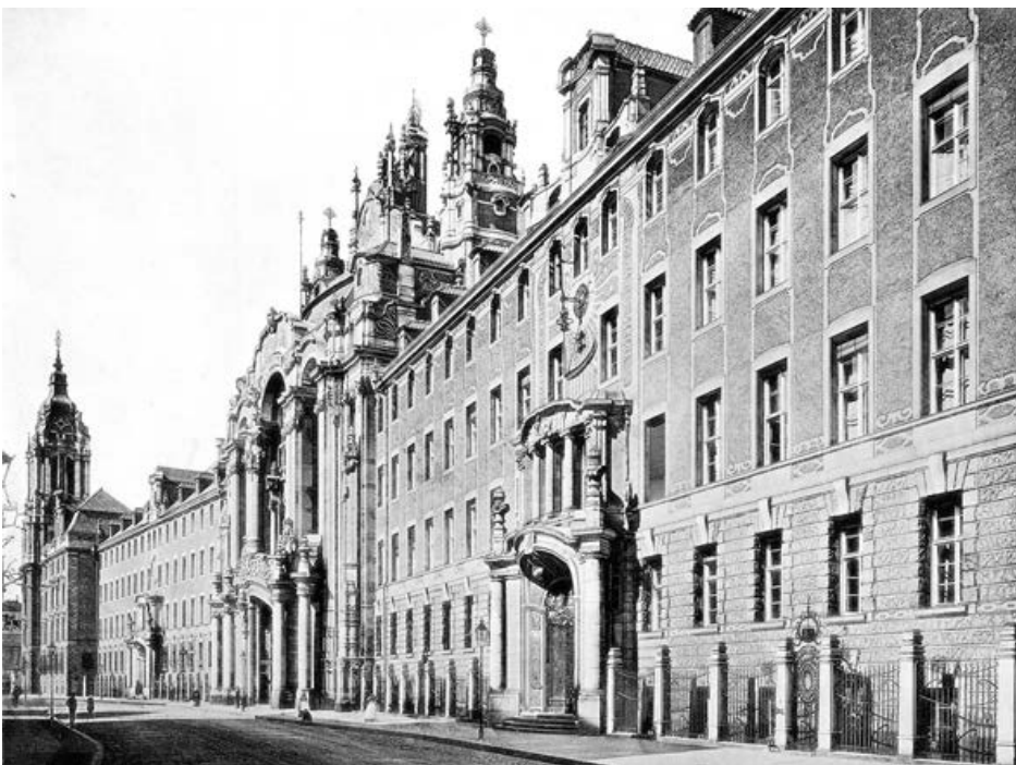
Bild 3.63: Amtsgericht Mitte, Front an der Neuen Friedrichsstraße, erbaut 1894-1904, Architekten Rudolf Mönnich, Paul Thoemer, Otto Schmalz, Foto: 1905
