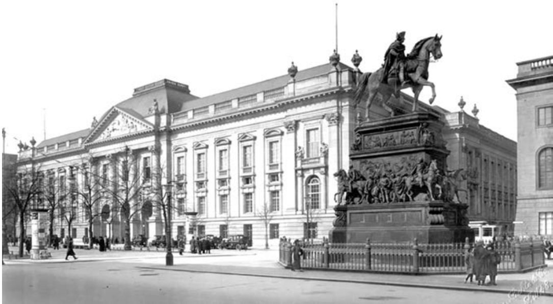
Bild 4.34: Königliche Bibliothek Berlin, Architekt: Ernst von Ihne, erbaut 1903-1914, Foto: um 1925, © Staatsbibliothek zu Berlin
