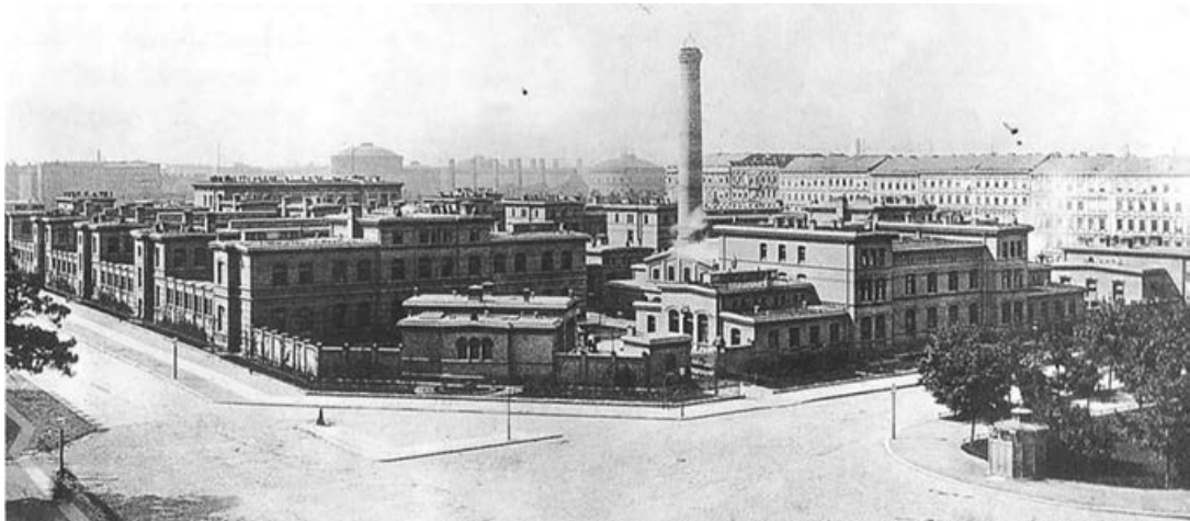
Bild 3.30: Städtisches Krankenhaus Am Urban , erbaut 1887-90, Architekt: Hermann Blankenstein, Ansicht von Südosten, rechts das Wirtschaftsgebäude, Foto um 1896
