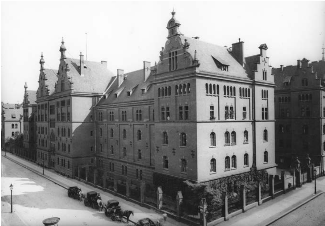
Bild 3.8: Kaserne des Garde-Kürassier- und Kasierin-Augusta-Garde-Grenadier-Regiments, Berlin, Jüterboger Straße/Friesenstraße, erbaut 1895, Architekten: Ferdinand Schönhals, Paul Heinrich Müssigbrodt, Erdmann Vetter, Foto um 1900, © Landesdenkmalamt Berlin
