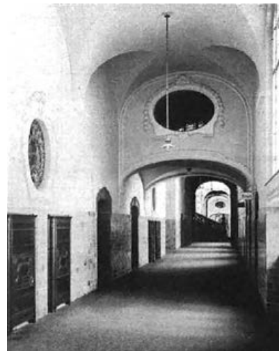
Bild 3.56: Das Neue Kriminalgericht Berlin-Moabit, „Flur im Erdgeschoß des Saalbaues mit brückenartigem Einbau für die Gefangenenzuführung“, erbaut 1906-1908, Architekten Carl Vohl und Rudolf Mönnich, Foto: 1908
