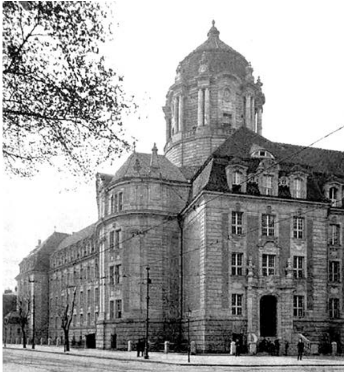
Bild 3.54: Das Neue Kriminalgericht Berlin-Moabit, erbaut 1906-1908, Architekten Carl Vohl und Rudolf Mönnich, Foto: 1908
