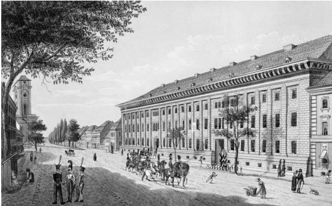
Bild 3.1: Lehr-Escadron-Kaserne, erbaut 1818, Architekt Karl Friedrich Schinkel, kolorierte Radierung um 1825 © Bildarchiv Foto Marburg
