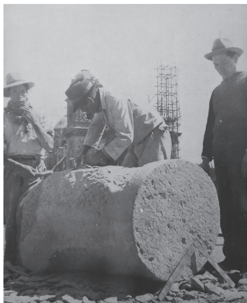
Figura 3. Énfasis en capacitación de la mano de obra local. Elaboración de las nuevas piezas de cantería para sustituir a las desaparecidas durante el terremoto.
