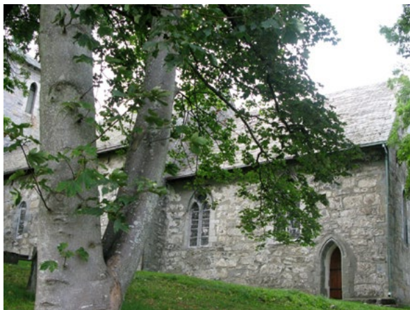
Figur 9. Olavskyrkja med plasseringa av søre korportal, og med murgjennomslaget for portalen godt synleg med døra som står i innerlivet i muren, inn mot koret. Loysinga syner at portalen er snudd mot eit lukka rom, som no er vekke, ved sorsida av koret. Foto: Marit S. Vea.
