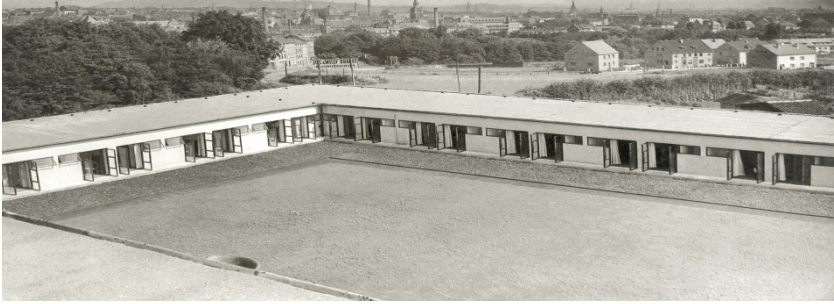
Ansicht des Innenhofes in Richtung Nordosten, 1930 (Quelle: Oellers / Böhmer 1997, Tafel 26)
