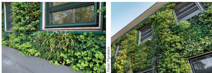
Fig. 4 – Dettagli dello strato vegetativo della parte alta e bassa del greenwall ATM Giambellino
