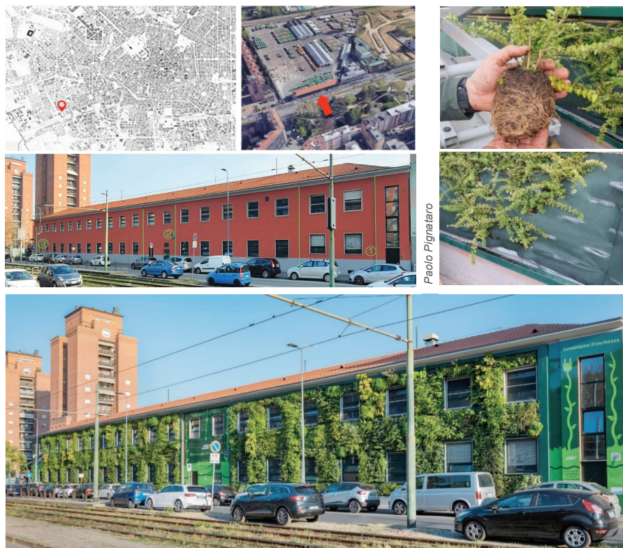
Fig. 3 – Localizzazione della parete, fase di posa delle piante e immagine prima e dopo la realizzazione
