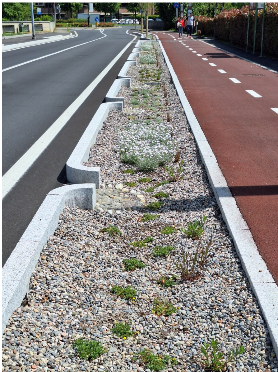
Fig. 3 – Raingarden di via Matteotti in Bovisio Masciago: dettaglio di area di bioritenzione (luglio 2023). Fonte: BrianzAcque Srl
