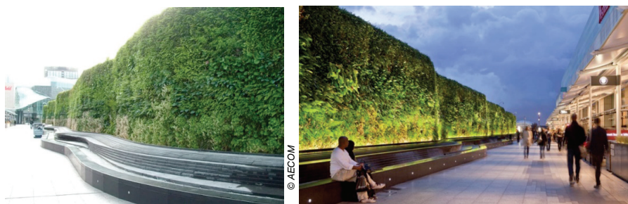
Fig. 1 – Visione diurna e notturna della parete sud, verso il centro commerciale
