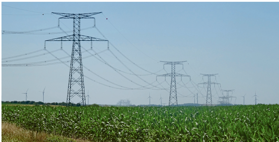
Figure 7.5. La ligne à haute tension Lonny-Seuil-Vesle au sein du parcellaire agricole et des parcs éoliens
