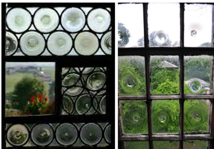
FIGURE 55. Vitrages utilisant des vitres fabriquées en verre couronne, on peut voir les traces circulaires liées à l'écrasement du verre encore pâteux.
