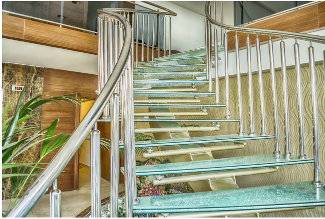
FIGURE 24. Exemple d'utilisation du verre trempé : escalier en verre trempé. L'amélioration des propriétés mécaniques du verre permet ainsi l'utilisation dans des conditions de sécurité et de durabilité bien meilleures que pour du verre ordinaire.
