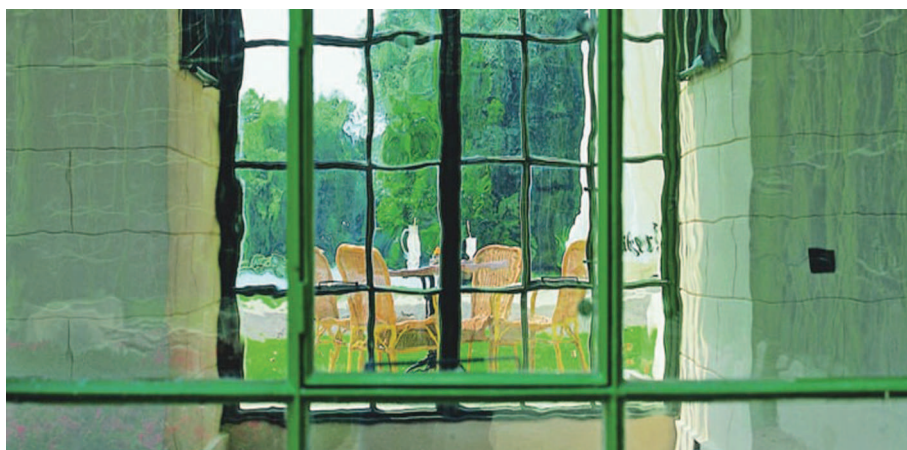
FIGURE 46. Vitrage ancien muni de vitres préparées par soufflage. Les vitres préparées par soufflage étaient irrégulières et souvent pleines de bulles. Ce phénomène n'était pas trop gênant pour laisser entrer la lumière ou voir de loin au travers du vitrage (l'œil accomode la vision et n'est pas sensible aux défauts situés à proximité). Par contre, en regardant de près les vitres, on s'aperçoit aisément des défauts. On peut retrouver ce type de vitres dans des bâtiments anciens. © DR.
