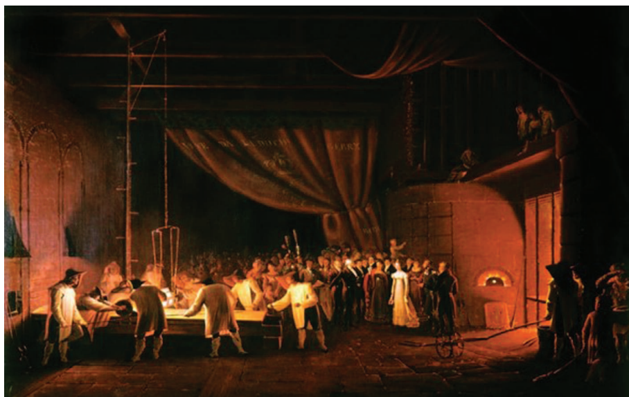
FIGURE 49. Visite de la duchesse de Berry à l'usine de Saint-Gobain en 1822. On y voit une démonstration de la coulée sur table, invention de la fin du XVIII e siècle. Le dépôt de verre fondu sur une table en acier bordée par des réglettes fixant l'épaisseur puis laminé par un rouleau permettait de faire des plaques de verre épaisses de grande taille qui, une fois doucies et polies, permettaient d'obtenir des miroirs de taille impressionnante et de qualité exceptionnelle. © Edouard Pingret / Archives de Saint-Gobain.
