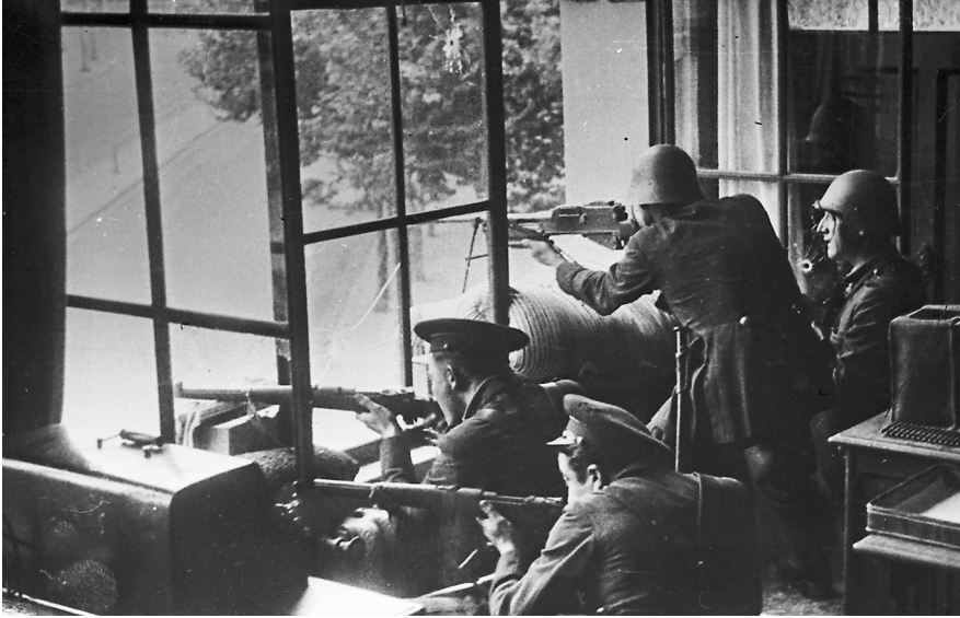
Abb. 8: Agustí Centelles, Gebäude der Compañía Telefónica, Juli 1936.
