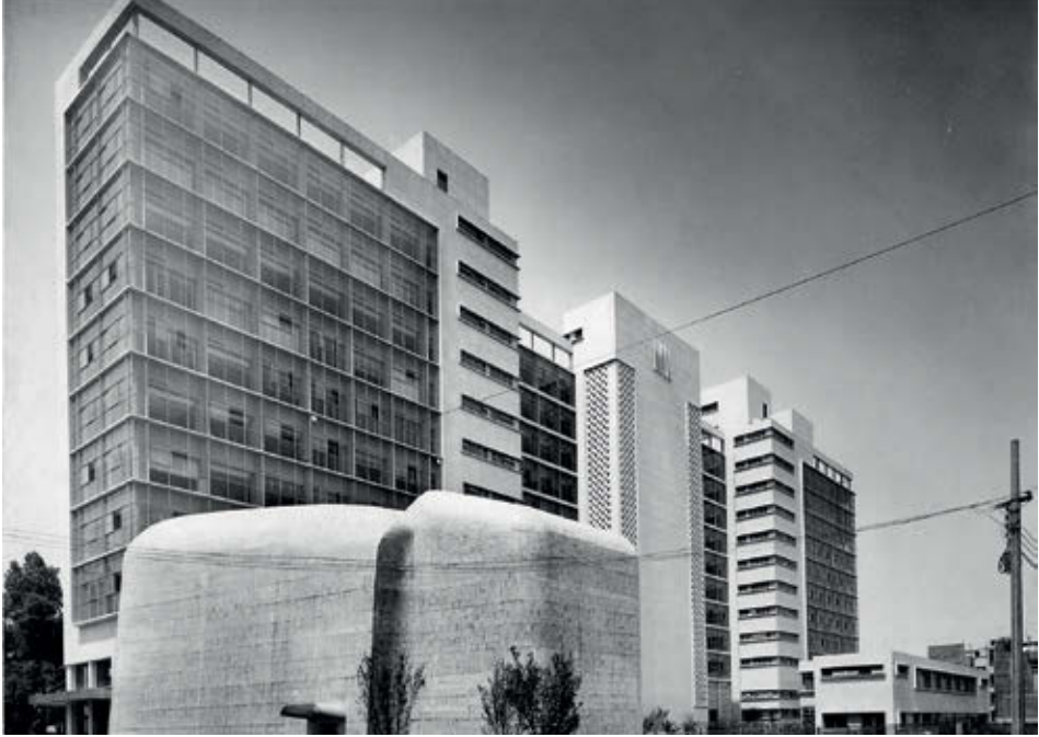
Abb. 155: Carlos Obregón Santacilia, Zentralgebäude des Instituto Mexicano del Seguro Social, 1948–50, Ansicht mit dem Auditorium im Vordergrund, Paseo de la Reforma, Mexiko-Stadt
