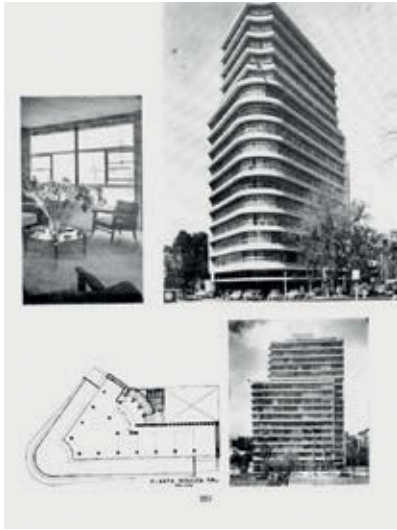
Abb. 158: Mario Pani und Jesús García Collantes, Bürogebäude, 1949–51, Außenansicht und Grundriss, in: Arquitectura/México 44 (1953), S. 223
