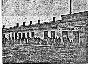
Наружный вид машиннаго отдѣла.
