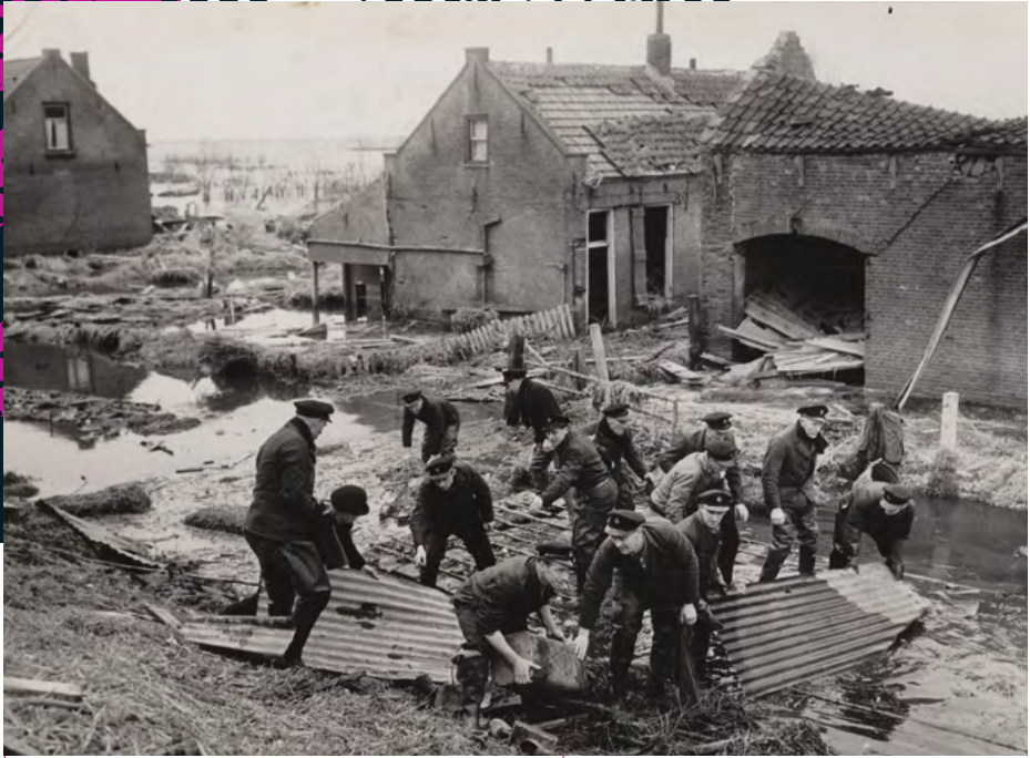
17 De Amsterdamse brandweer aan het werk in Oude Tonge (Goeree-Overflakkee).
