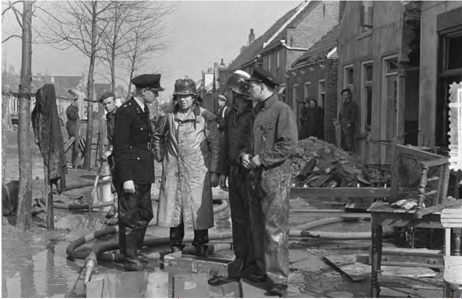
11 De Haagse brandweer aan het werk in Stellendam op Goeree-Overflakkee.
