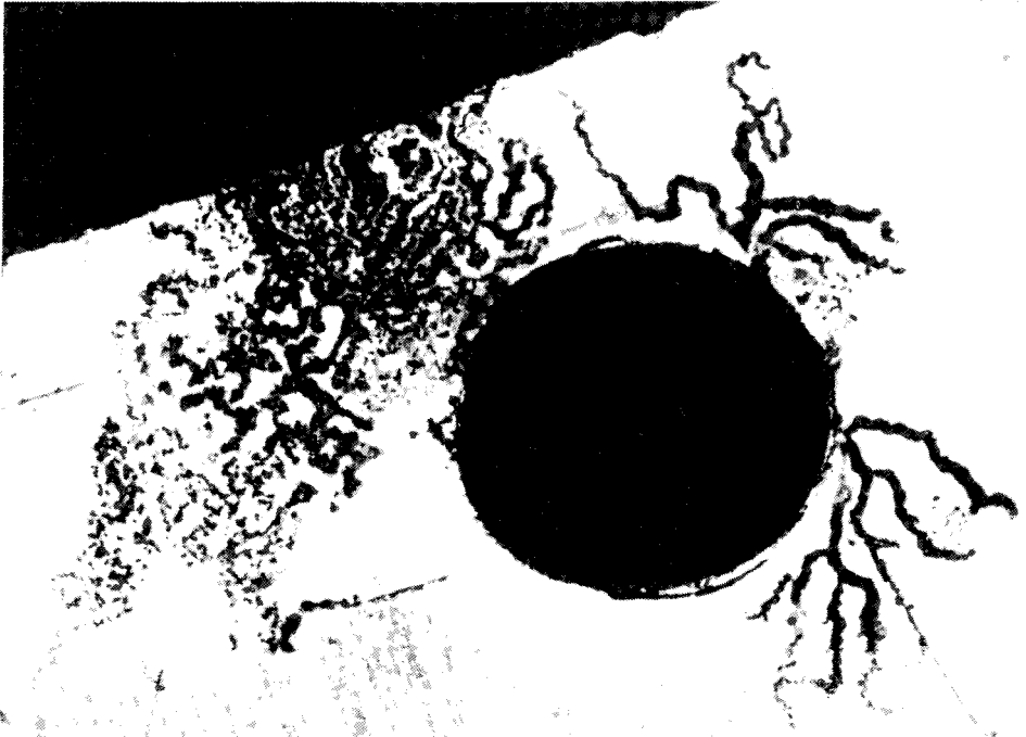
Figure 9. Corrosion filiforme en bordure de trou de rivet. Observation après élimination de la peinture.
