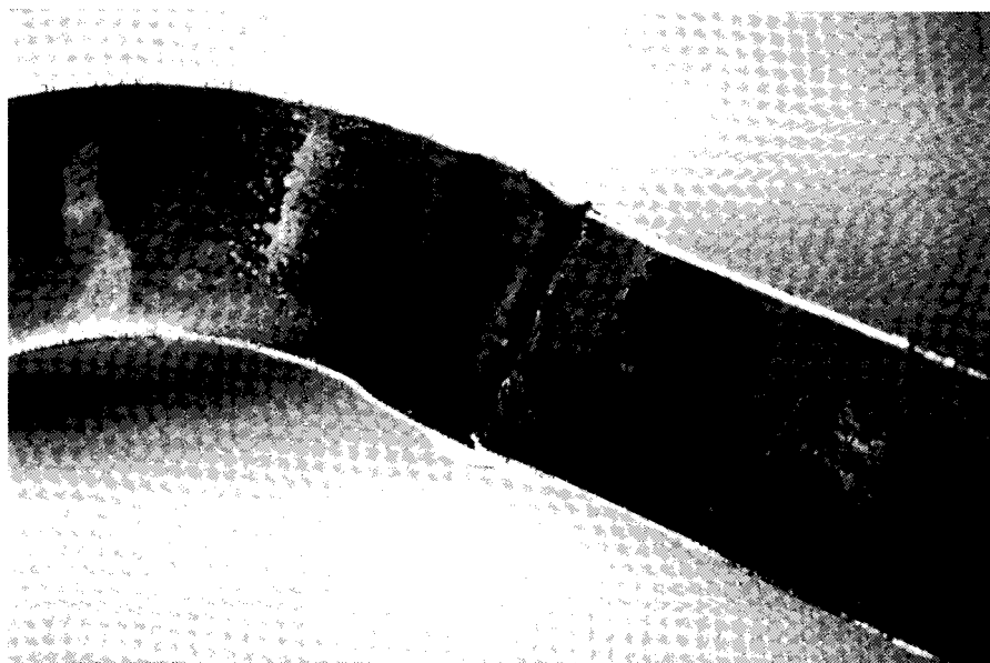
Planche 8. Corrosion dans zone de brasage : influence de la brasure, des oxydes thermiques,...
