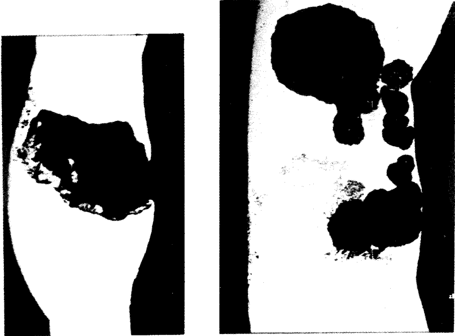
Figure 7. Piqûres observées sur les tuyauteries en acier AISI 304 L du circuit incendie de la centrale de Cattenom [8].
