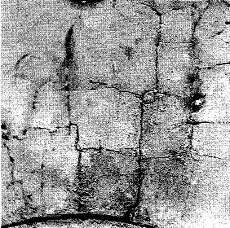
Fig. 3.32. Faïençage par fatigue thermique du canal d'injection du métal dans le cas du moulage d'alliages légers en moule d'acier (cliché ENSAIS-LMCM).
