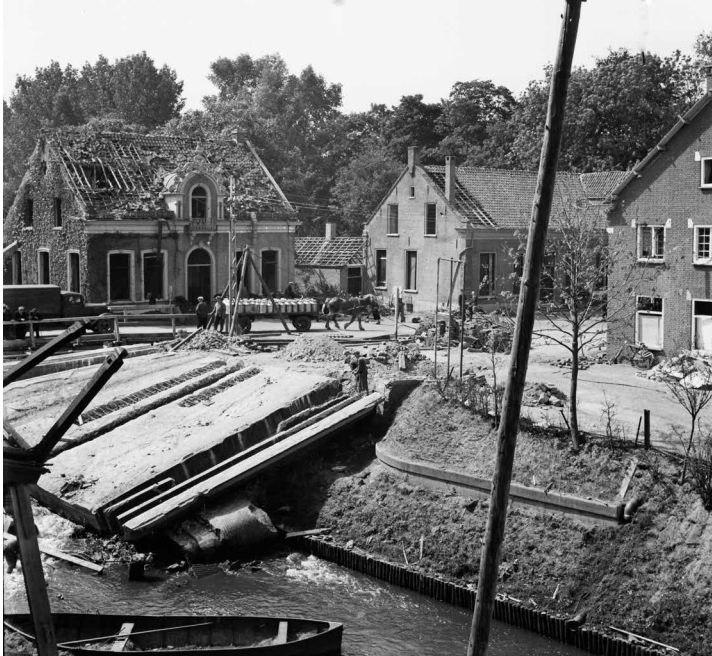
Oorlogsschade aan de Aa-brug in Veghel in mei 1940 (Collectie Johan van Eerd/BHIC)
