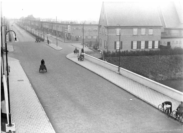
Bartenbrug met zicht op de Graafseweg, om de hoek van het Lariksplein, december 1937 (Erfgoed 's-Hertogenbosch/Fotopersbureau Het Zuiden)
