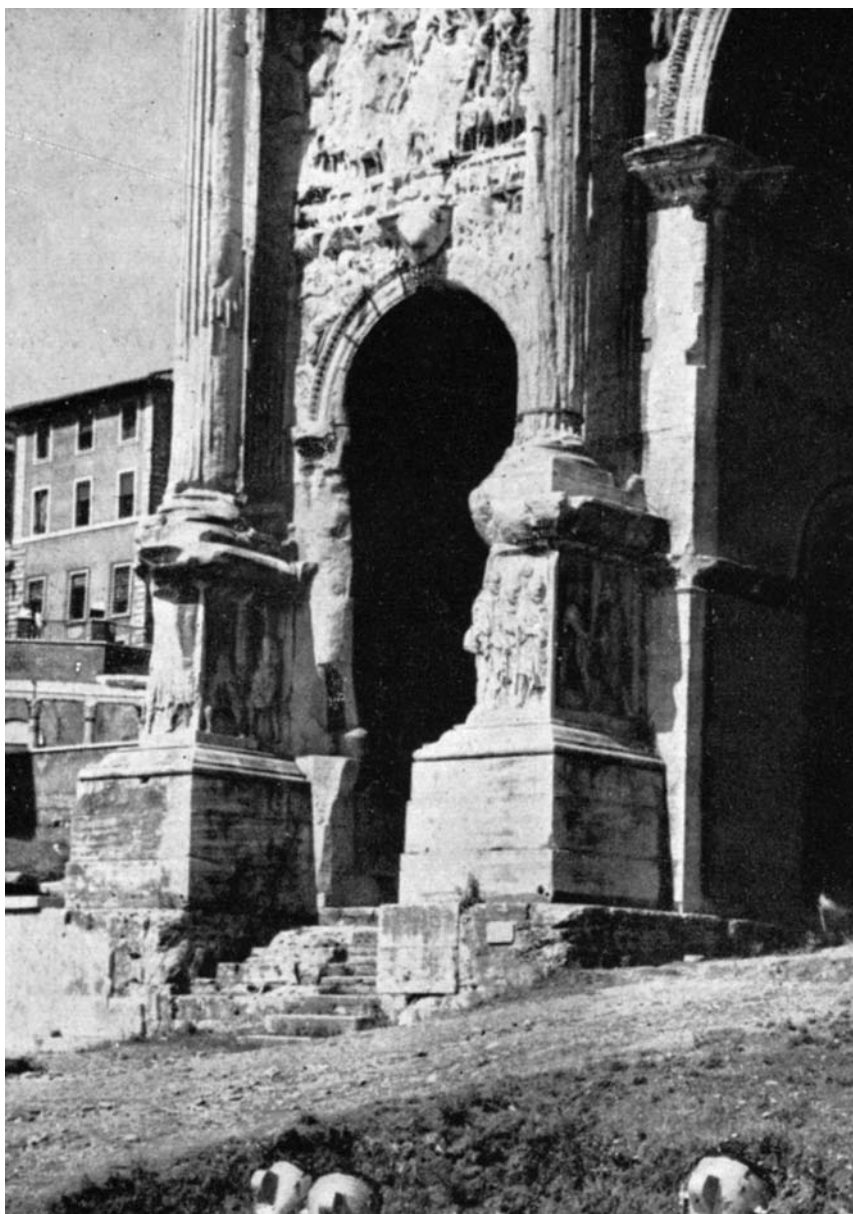
45. Bogen des Septimius Severus, Forum Romanum, Rom, Blick auf Südostdurchgang (BRILLIANT 1967, Tf. 7b)
