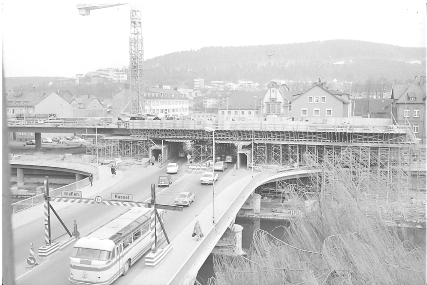
Abb. 2: Autobahnhochbrücke vor dem Bahnhof im Bau
