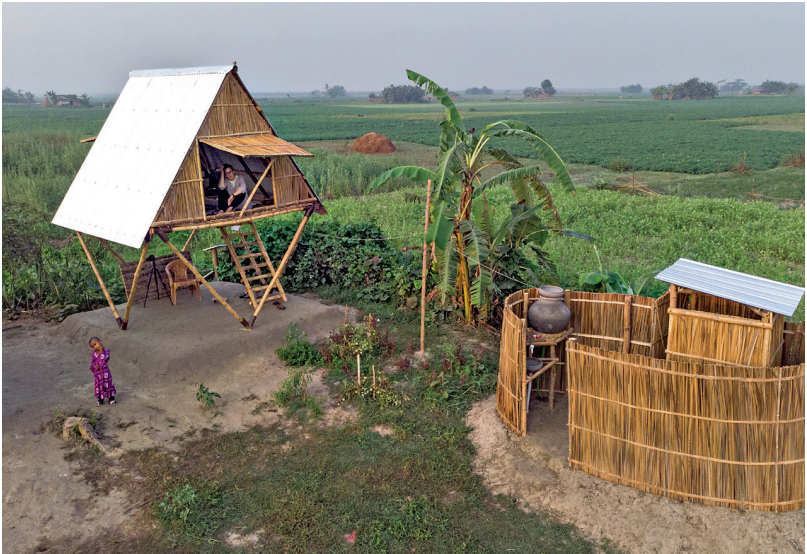
Khudi Bari – kleines Haus – nennen sich die aufgeständerten Häuschen aus Bambus zum Schutz vor Überflutungen, entworfen von Marina Tabassum Architects.
