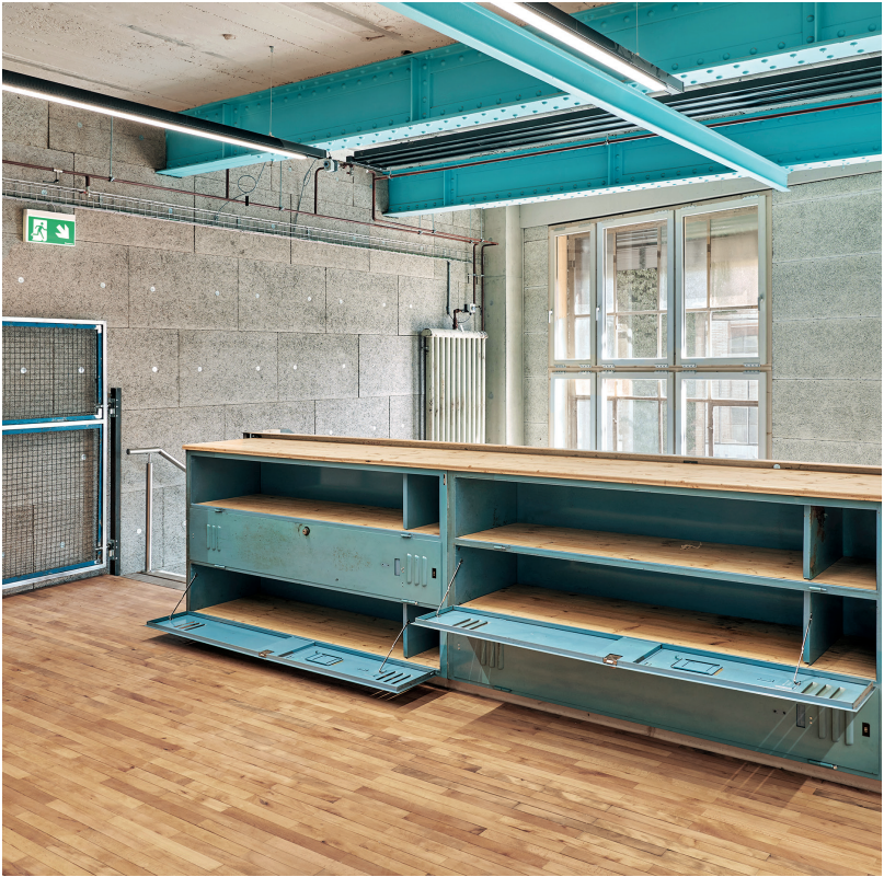
Ehemalige Spinde dienen als Absturzsicherung im neu geschaffenen Werkstattbereich des Projekts K.118.
