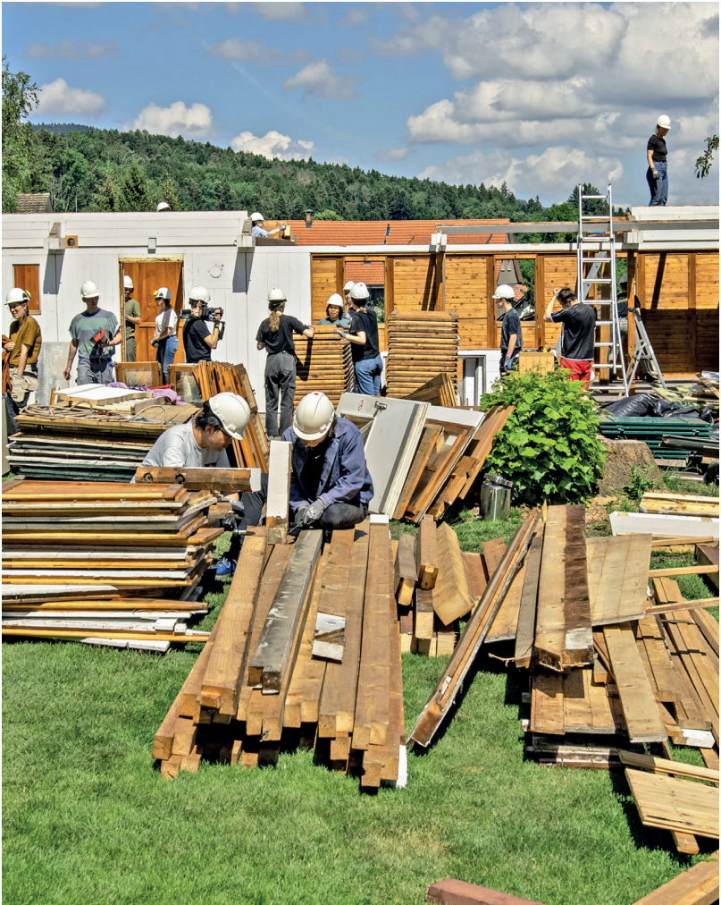
Das Abbruchmaterial wird von Hand, mit Laserscannern und Robotern sortiert, mit QR-Codes markiert und in einer Datenbank erfasst.
