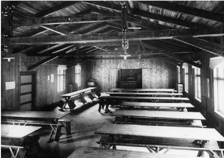
Abb. 3: Baracke (Brunsbüttel?) mit Speisesaal und Altarraum, 1911. Quelle: Heimatmuseum Brunsbüttel; http://www.dithmarschen-wiki.de/images/1/1e/Baracken3.jpg (Zugriff: 14.07.2016)
