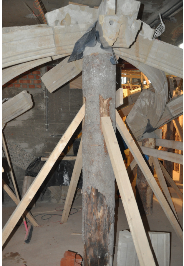
Abb. A.3 Ständer zur Positionierung der Rippenkreuzungen
