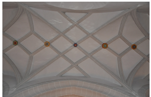
Abb. 3.91 Gewölbe im nördlichen Seitenschiff
