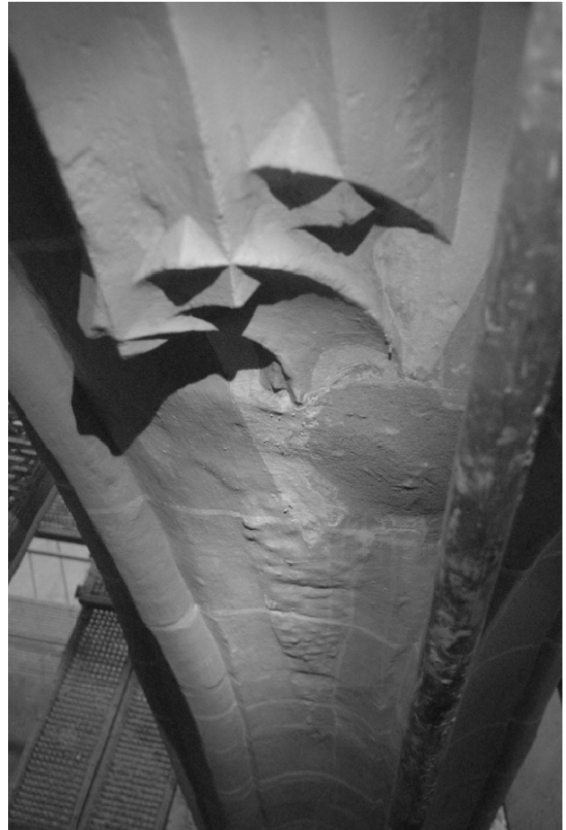
Abb. 3.94 Abgearbeiteter und neu angesetzter Gewölbeanfänger; Foto: WITTMAR, WITTMAR - TOMASCHEK 2011, Teil II
