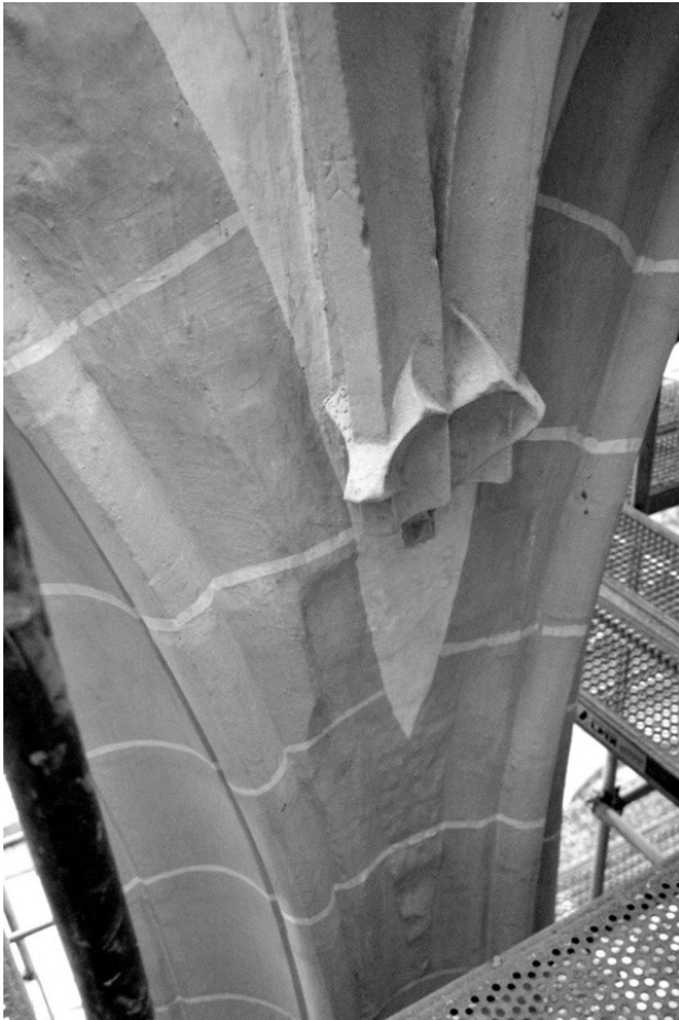
Abb. 3.93 Abgearbeiteter und neu angesetzter Gewölbeanfänger; Foto: WITTMAR, WITTMAR - TOMASCHEK 2011, Teil II
