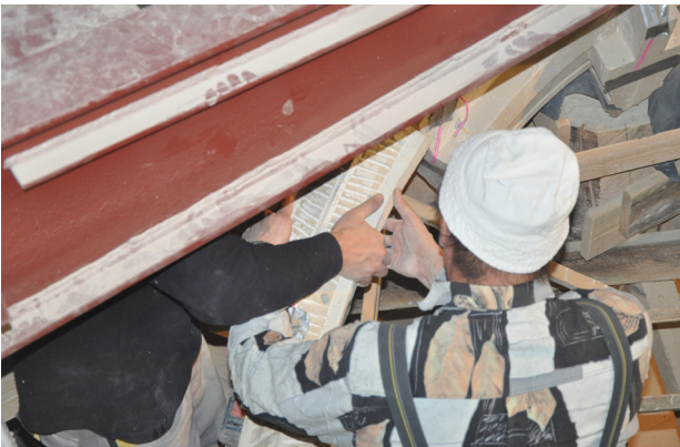
Abb. A.6 Versetzen eines Rippenbogenwerksteines
