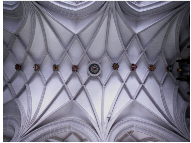
3.3 Chorgewölbe nach der Sanierung 2011
