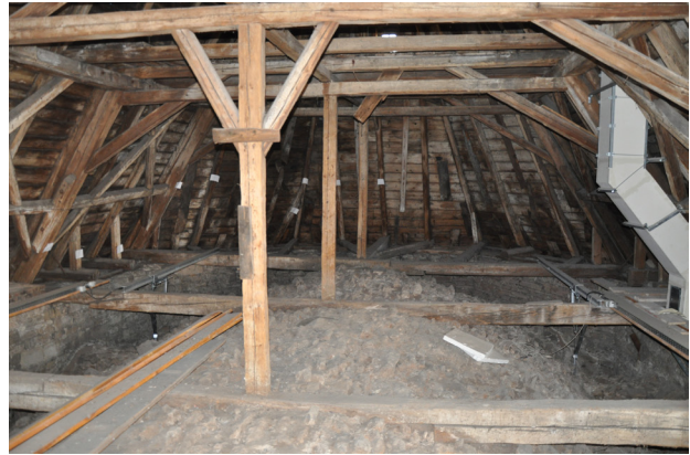
3.5 Durch die Gewölbe geführte Zerrbalken des Chordaches
