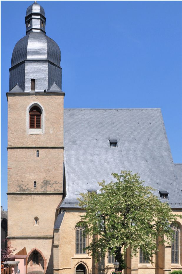
1.1 Die Kirche St. Peter und Paul nach der Sanierung des Kirchenschiffdaches, Ansicht von Süden
