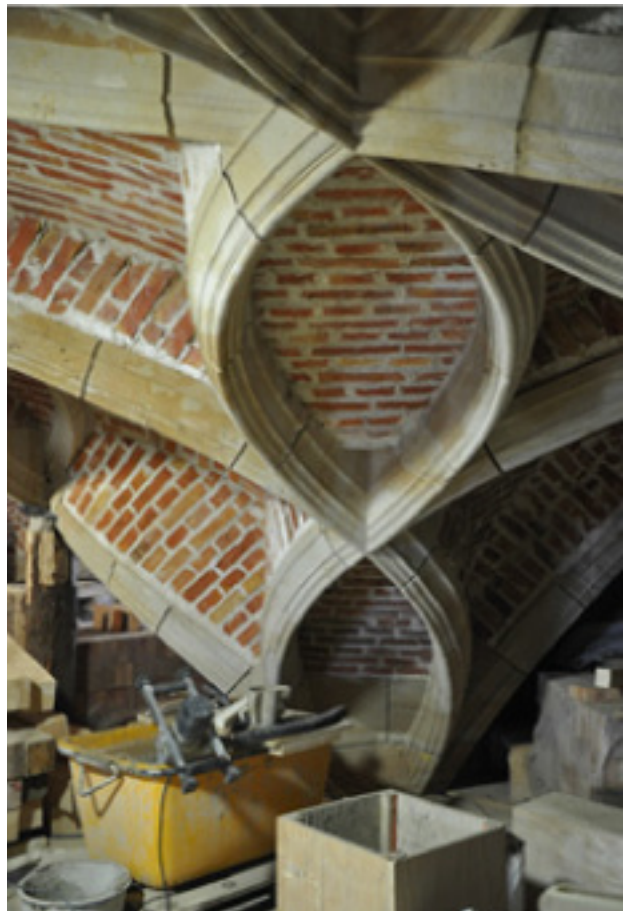
Abb. A.11 Schlingrippengewölbe - Ansicht von unten
