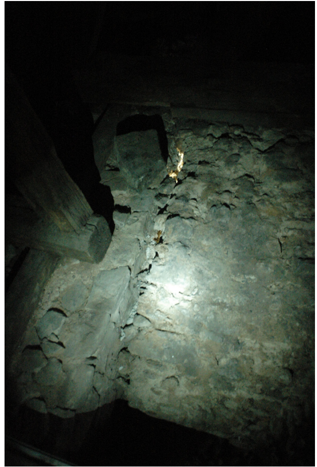
1.3 Abriss einer Gewölbekappe von der Schildwand; Foto: WITTMAR, WITTMAR - TOMASCHEK 2011, Weimar
