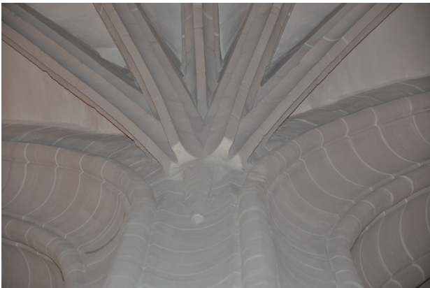
Abb. 3.95 Alter Gewölbeanfänger mit Vermittlung zum neuen Gewölbeanfänger
