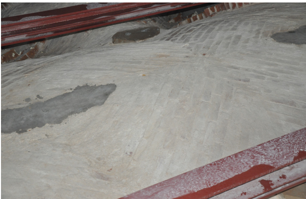
Abb. A.12 Gewölbekappe - Ansicht von oben
