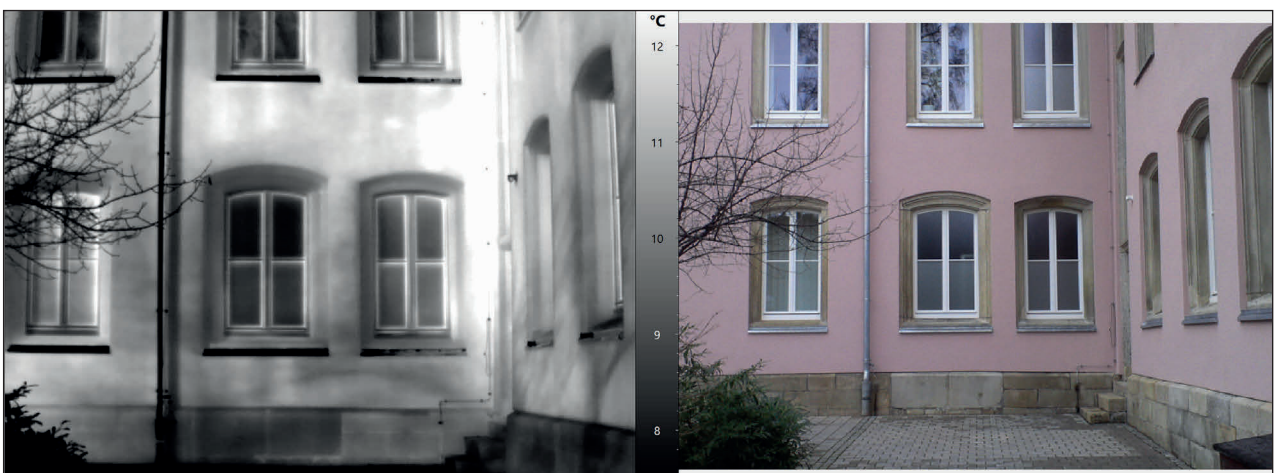
7 Schatteneffekte durch Vegetation. Obwohl die zugehörige Photographie zum Zeitpunkt der Aufnahme keinen Schattenwurf und daher keine direkte Sonneneinstrahlung mehr zeigt, sind die Verschattungen der Äste auf der Fassade rechts in den Minuten vor der Aufnahme noch deutlich als kältere „thermische Schatten“ sichtbar. Die zeitliche Verzögerung bis zu vollständigen Auskühlung der lokal solar angeregten Bereiche ist unbedingt zu beachten. Ggf. muss die Thermographie von Bauteilen mit unklaren Solarstrahlungseinflüssen zu einem späteren Zeitpunkt bzw. vor Sonnenaufgang oder nach Sonnenuntergang wiederholt werden.
