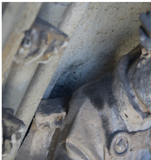
15 Köln, Hohe Domkirche Sankt Petrus, Westfassade, Petersportal, Archivoltenfigur Hl. Augustinus (IIL), sichtbare Auskerbung in der Archivoltenkehle für die Einhängung der Figur.
