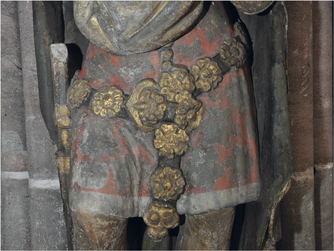
16 Nürnberg, Pfarrkirche St. Lorenz, Langhaus, Ausschnitt der unteren Gewandpartie des jüngsten Königs; Auf einer ockerfarbenen Grundierung finden sich – stark geschädigt – die Fassungen. Unter der grünen Sichtfassung des Mantels ist mikroskopisch eine violette Farbfassung zu erkennen.
