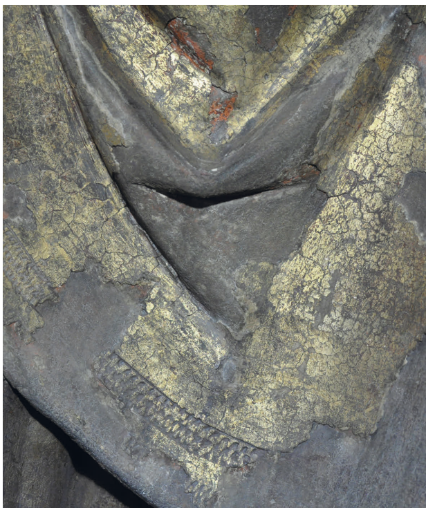
14 Nürnberg, Pfarrkirche St. Lorenz, Langhaus, Detail am Mantel Mariens, Sichtfassung gestaltet mit Pressbrokaten. Der Saum erhält durch Wuggelung plastisch ausgearbeitete Ornamente.
