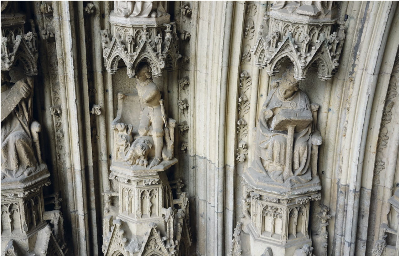
7 Köln, Hohe Domkirche Sankt Petrus, Westfassade, Petersportal, III L und III L, unterschiedliche Sockel der Archivoltenfiguren in der untersten Reihe der Konsolbaldachine und der zweiten Konsolbaldachinreihe.
