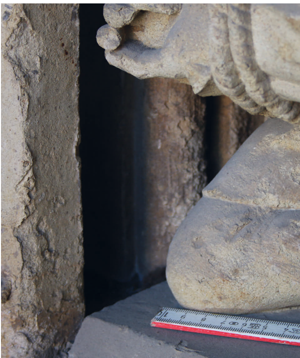
8 Köln, Hohe Domkirche Sankt Petrus, Westfassade, Petersportal, Übergänge zwischen den Werksteinen des Tympanons und der Architekturprofile, Szene des Martyriums.
