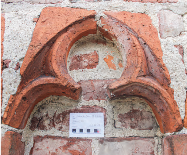
Abb. 3: Unterdießen, St. Nikolaus (15. Jh.); geschnittene Formsteine des umlaufenden Kleeblattbogen-Frieses an der Turmtraufe [Eckstein 2018].
