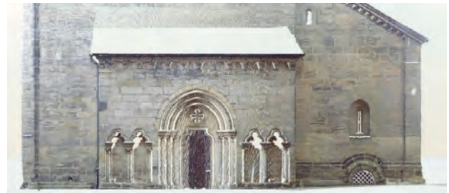
Abb. 2: 3D-terrestrischer Laserscan der St.-Veits-Pforte im größeren Kontext des Nordquerhauses am Bamberger Dom [Hess 2018].
