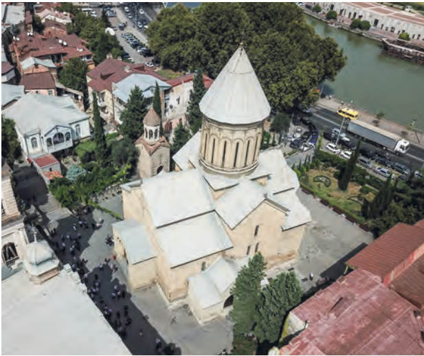
Abb. 1: Sioni-Kathedrale in Tbilisi, Georgien. Die Drohnenaufnahmen mit UAV DJI Mavic Pro [Luhmann et al. 2019].
