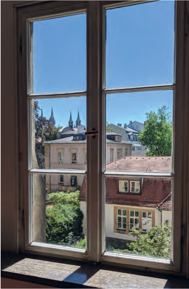
Abb. 4: Blick durch ein Fenster mit leichten Verzerrungseffekten historischer Scheiben am Beispiel des Markushauses in Bamberg [Bellendorf 2019].
