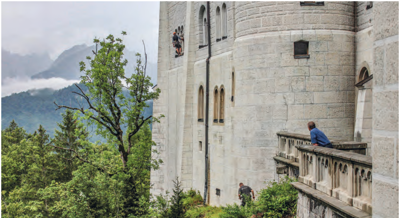
Abb. 2: In über zehn Metern Höhe – vom Boden des Ritterbades aus gezählt – brachte ein Kletterteam eine Metallplatte an, um die Mauer zu durchröntgen. [Münchener Büro für Denkmalpflege Schmickl & Umminger 2019].
