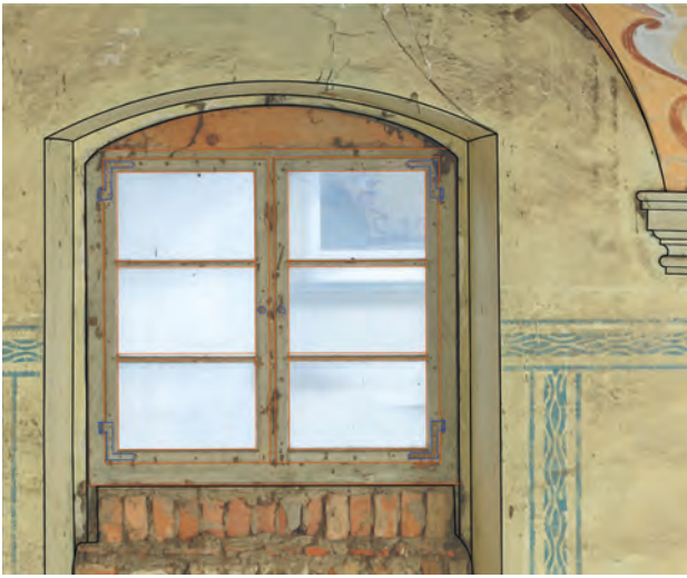
Abb. 1: Mühlhausen (Lkr. Höchststadt/Aisch), ehem. Synagoge, Fenster des ehem. Betsaales. Orthophoto mit Imm-Auflösung berechnet aus SfM-Modell. Darauf basierend wurden in CAD ausgewählte Bauteilkanten unter Berücksichtigung der Bauteilloge nachkonstruiert [Giese 2020].
