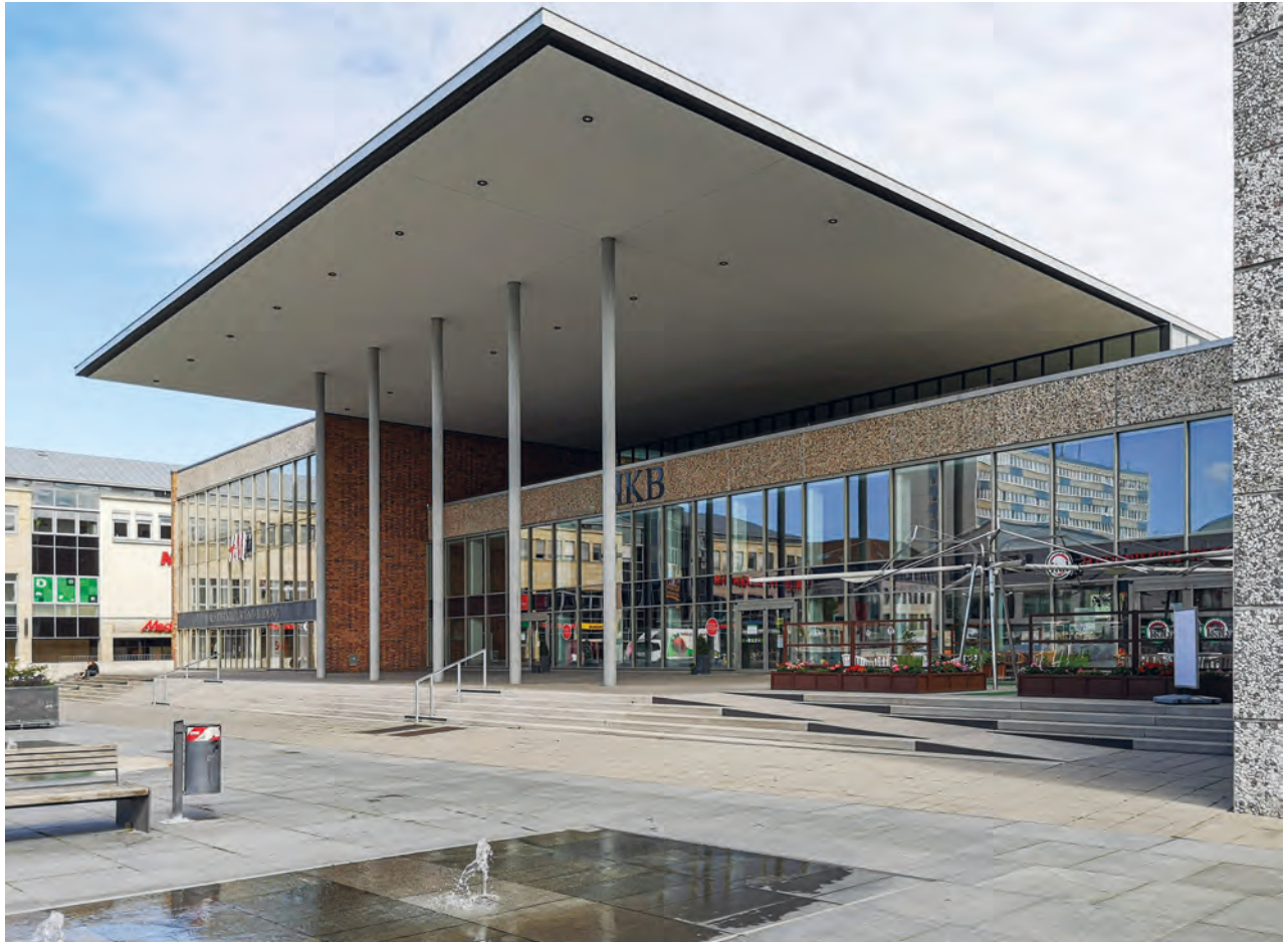
Abb. 5: Eines der Fallbeispiele, das im Projekt bearbeitet wird, ist das Haus der Kultur und Bildung in Neubrandenburg [Stackmann 2020].
