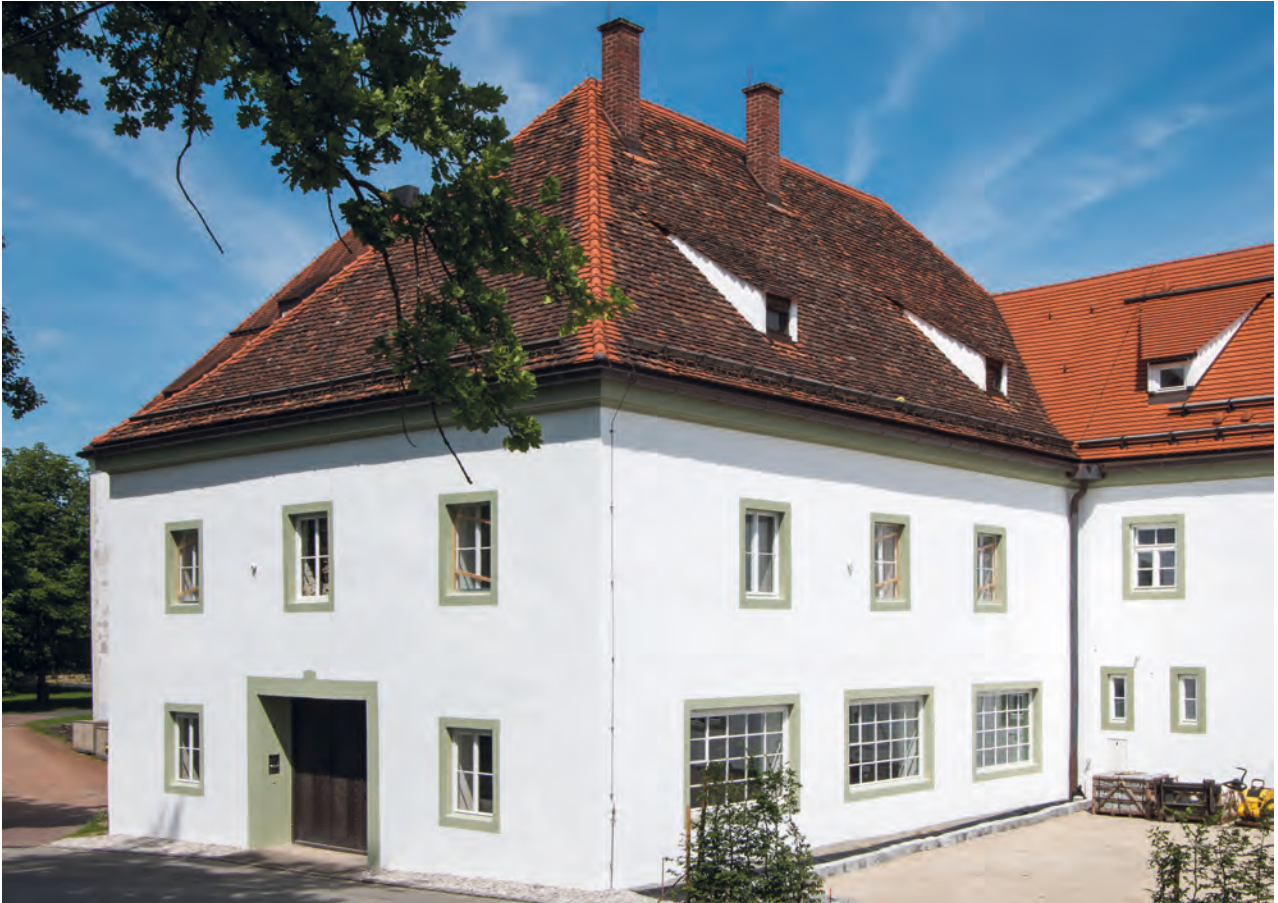
Abb. 3: Die Fassade der Alten Schäferei in Benediktbeuern wird - wie viele andere Denkmalfassaden - von verschiedenen Fenstertypen geprägt [Fraunhofer IBP 2016].
