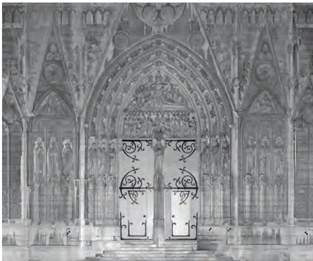
Abb. 1: Ansicht des Südportals als Orthofoto auf Grundlage der Punktwolke [Tenschert 2019].
