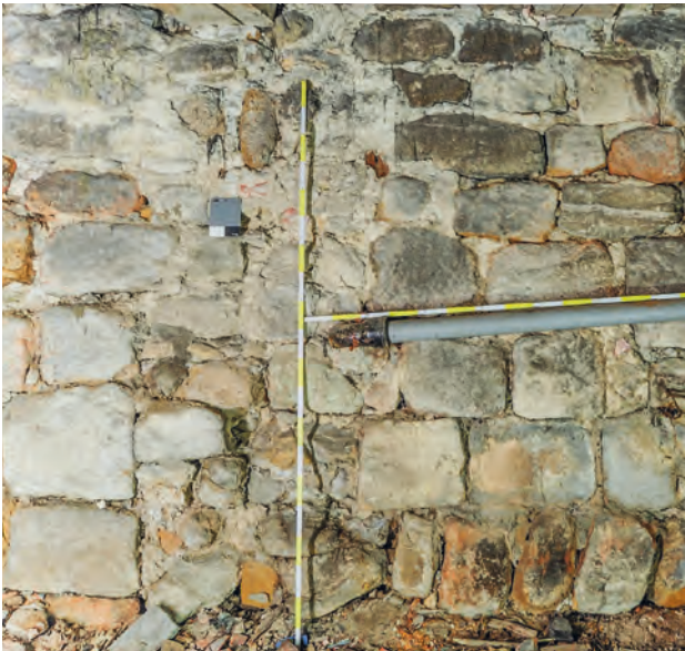
Abb. 1: Die Befundstelle im Raum 01.03 zeigt Reste einer abgebrochenen Mauer und lässt auf das historische Bodenniveau schließen [Gransche / Saele 2017].
