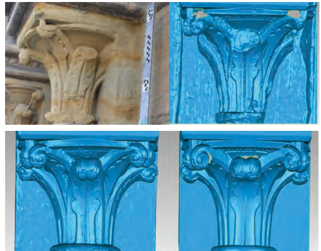
Abb. 3: (v. oben li.nach unten re.) Mittleres Kapitell in-situ, 3D-Scans nach der digitalen Aufarbeitung im Vergleich (Original, 3D-Druck aufmodelliert mit Plastilin, Steinmetz-Arbeit) [Hess 2020].
