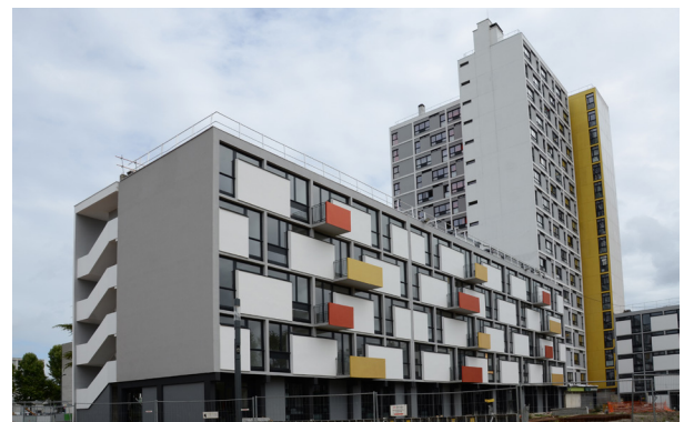
Abb. 5: Cité de l'Etoile in Bobigny nach der vom Originalzustand inspirierten Sanierung (08.08.2021)
